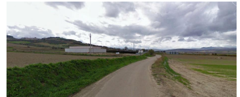
Figura 13 – Attraversamento cavidotto esterno in area di rispetto zona di interesse archeologico "Faragola" – viabilità comunale
