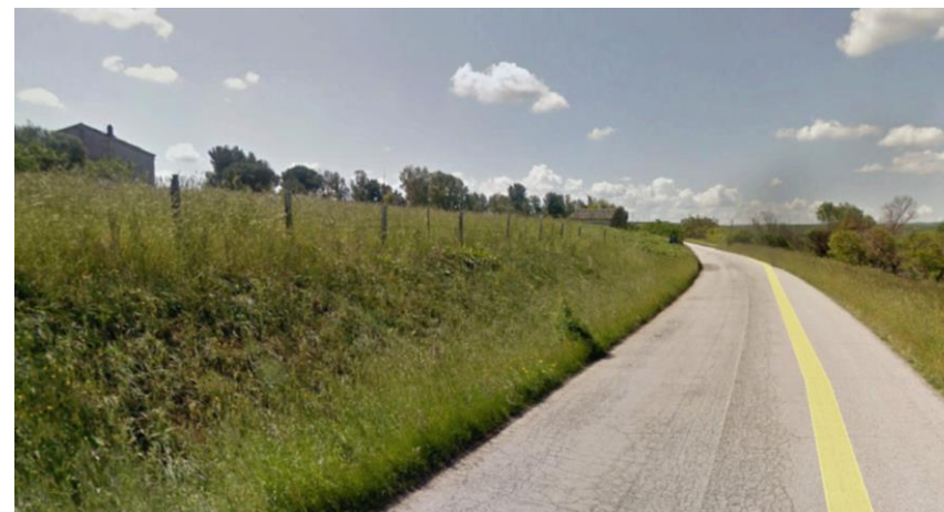
Figura 9 – Attraversamento cavidotto esterno in area di rispetto "Masseria Conte di Noia" – viabilità esistente SP 88
