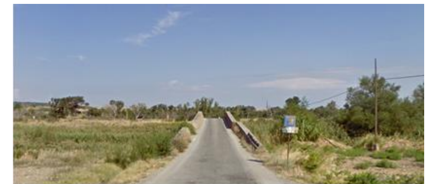
Figura 14 – Ponte d'Ascoli Romano sul Torrente Carapelle – SP105
