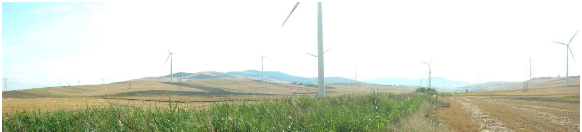
Fotografia n. 22 - Corridoio ecologico “Fosso Traversa e Pozzo Pascuscio” del PPTR verso ovest interessato dal cavidotto interrato MT esterno: l’attraversamento del cavidotto interrato esterno avverrà con sistema T.O.C. (Trivellazione Orizzontale Controllata) evitando quindi il danneggiamento della vegetazione naturale del canale; in fondo area montano-collinare Monti Dauni Meridionali.
