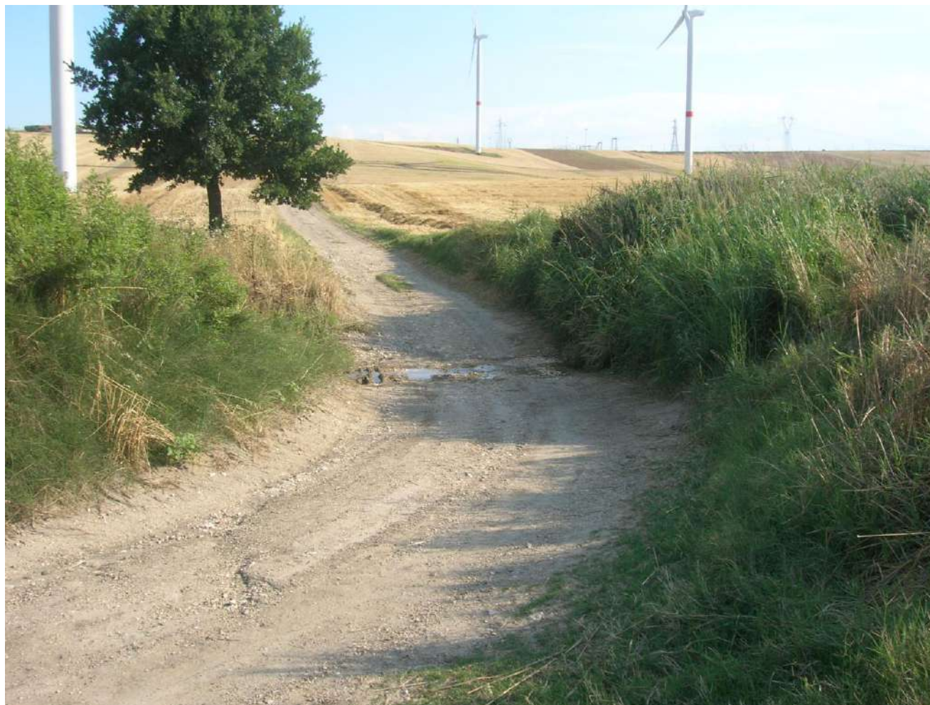
Fotografia n. 23 - Corridoio ecologico “Fosso Traversa e Pozzo Pascuscio” del PPTR verso ovest interessato dal cavidotto interrato MT esterno: l’attraversamento del cavidotto interrato esterno avverrà con sistema T.O.C. (Trivellazione Orizzontale Controllata) evitando quindi il danneggiamento della vegetazione naturale del canale; in fondo area montano-collinare Monti Dauni Meridionali.
