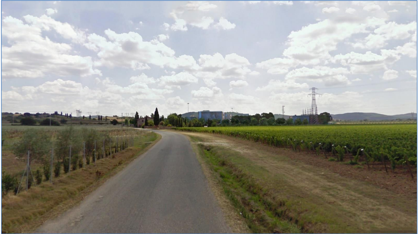
Figura 3-5 - Post operam Punto B
