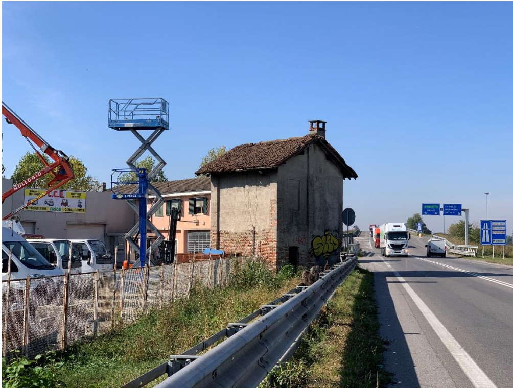
Fabbricato da demolire alla sez. TP-14bis
