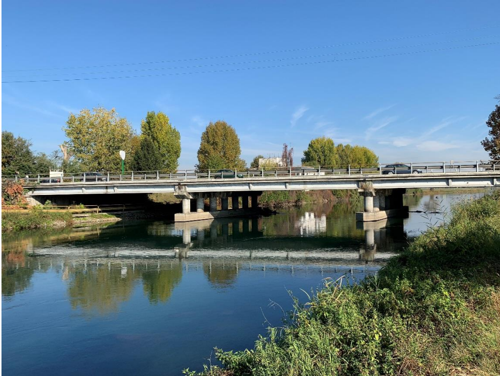
Ponte da demolire sul canale Muzza (vista da sud)
