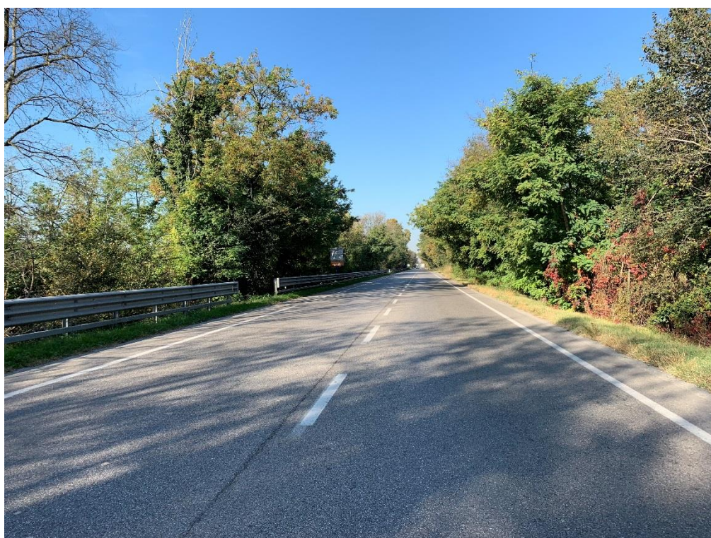
Viabilità attuale della SP ex SS415 alla sez. TP-122
