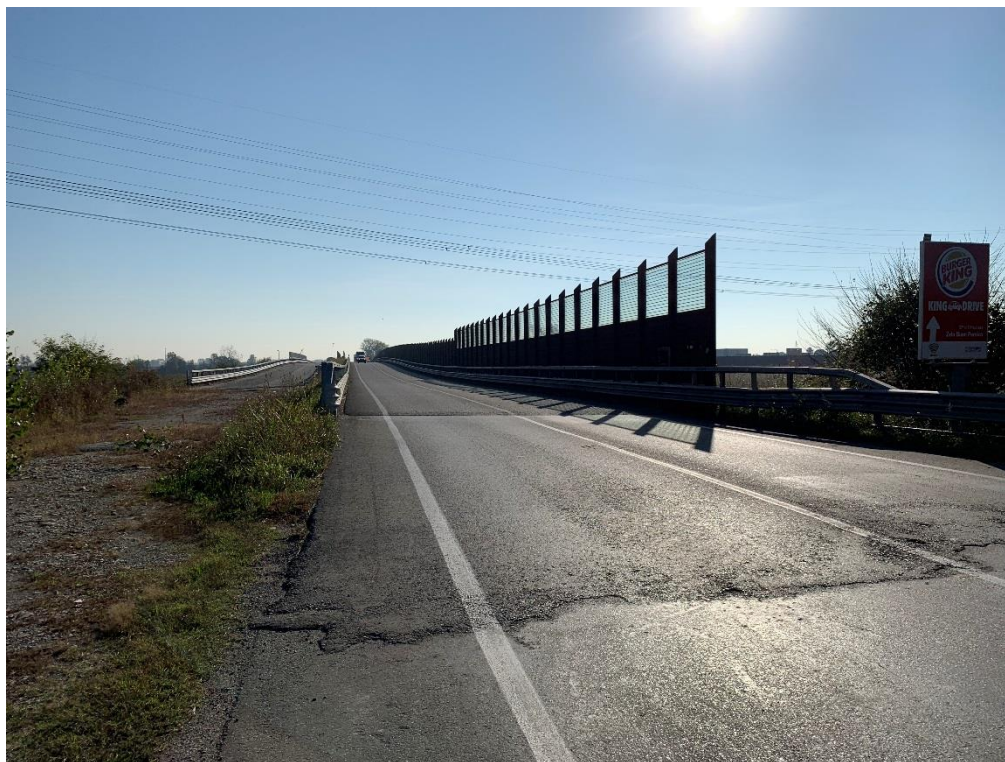
Inizio intervento a est
