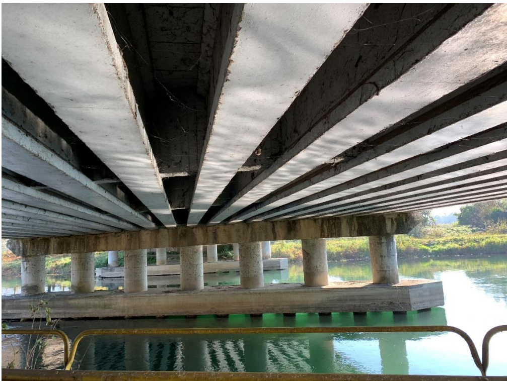
Vista sistema strutturale ponte da demolire sul Canale Muzza
