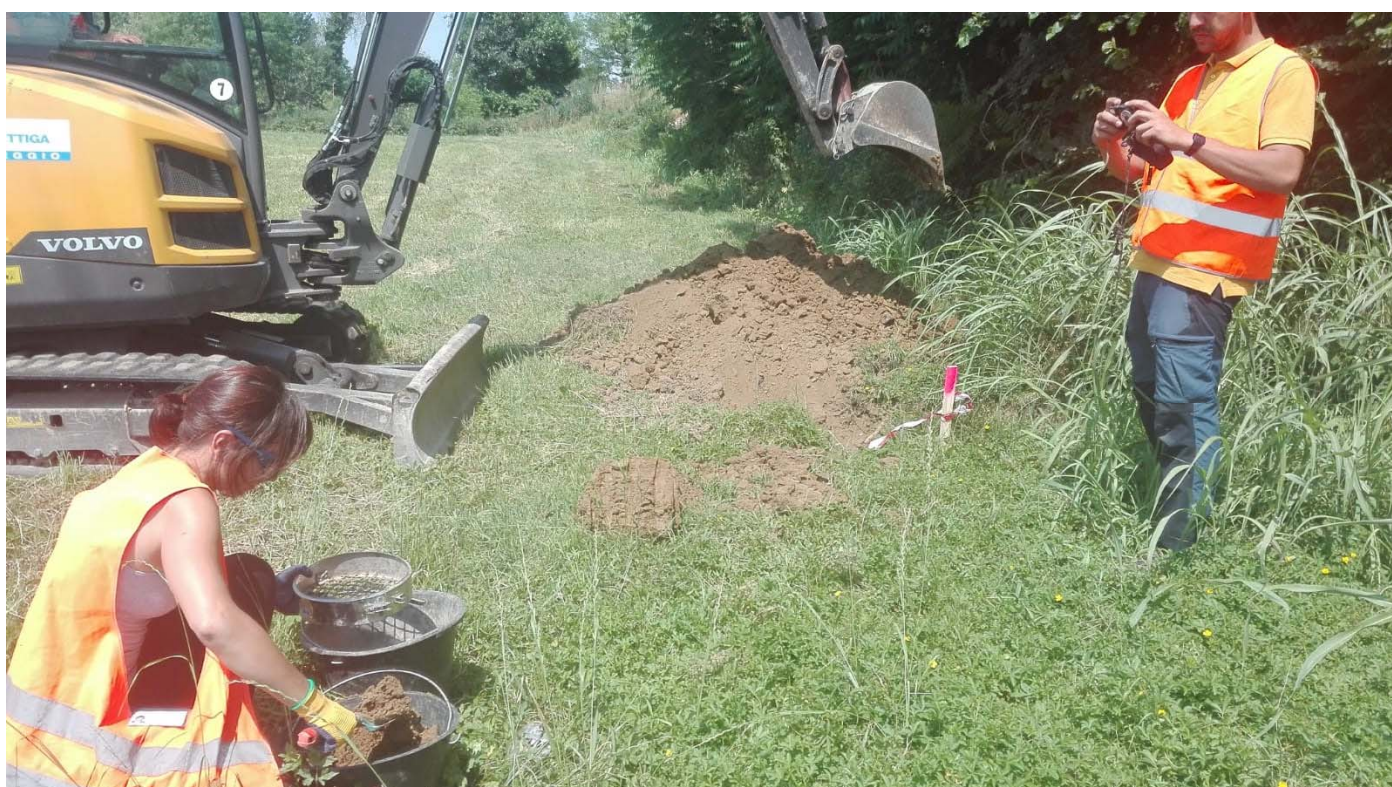
FOTO N. 1 : APERTURA TRINCEA ESPLORATIVA E PRIMA FASE DI CAMPIONAMENTO
