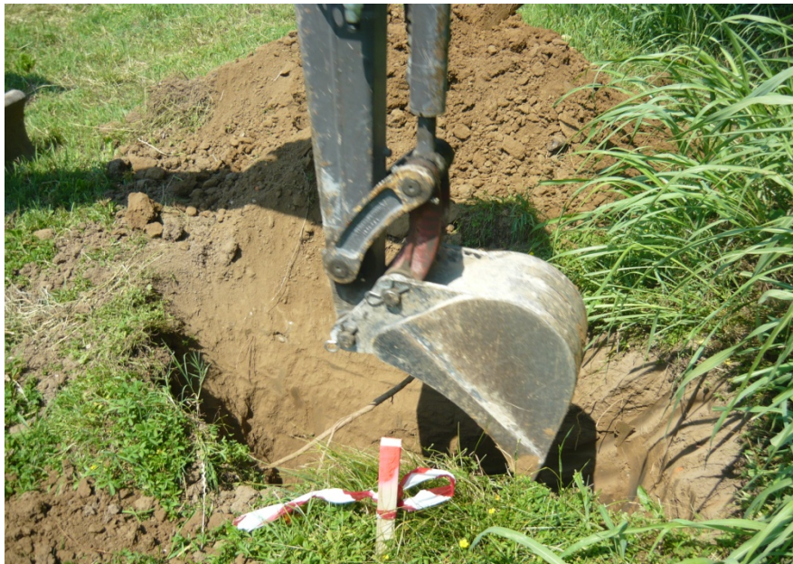
Foto n.1 : scavo trincea di esplorazione con l'ausilio dell'escavatore
