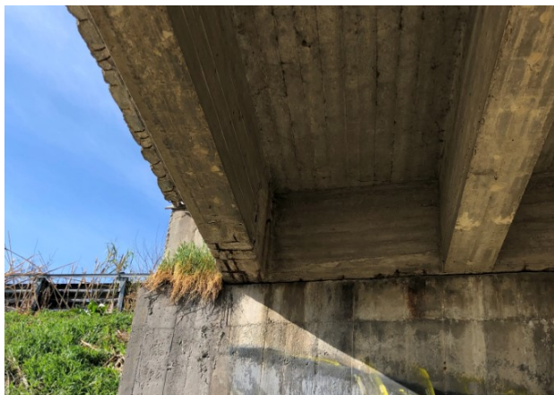
Figura 19: Particolari di degrado del ponte al km 152+00
