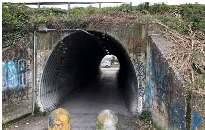
Figura 10: Sottopasso pedonale al km 153+600
