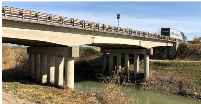
Figura 5: Ponte a 3 campate al km 152+00
