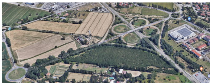
Figura 12: Svincolo a quadrifoglio al km 149+800
