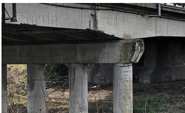
Figura 20: Particolari di degrado del ponte al km 153+350
