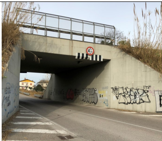
Figura 9: Sottopasso al km 153+500
