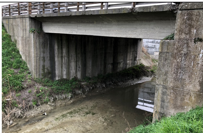
Figura 3: Ponte ad 1 campata al km 151+650
