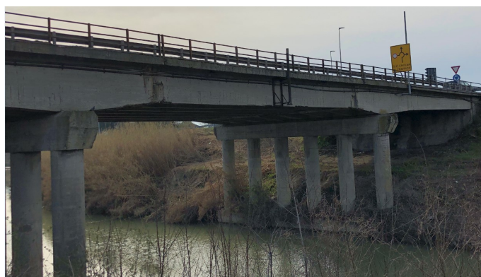
Figura 8: Ponte a 3 campate al km 153+350
