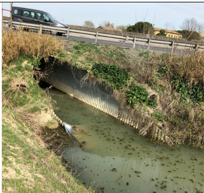
Figura 1: Tubolare presente al km 148+900
