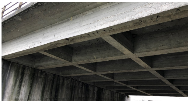
Figura 18: Particolari di degrado del ponte al km 151+650
