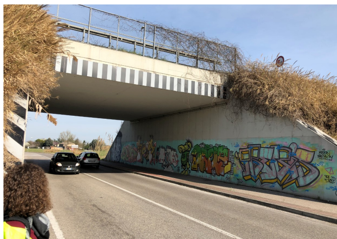
Figura 4: Sottopasso al km 151+900
