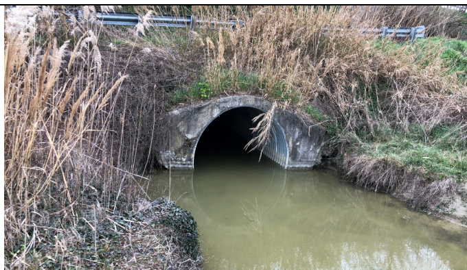
Figura 6: Tubolare al km 152+100
