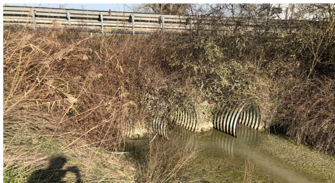
Figura 7: Tubolare al km 152+700
