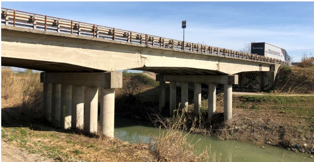
Figura 15: Vista del ponte sul fiume Montone
