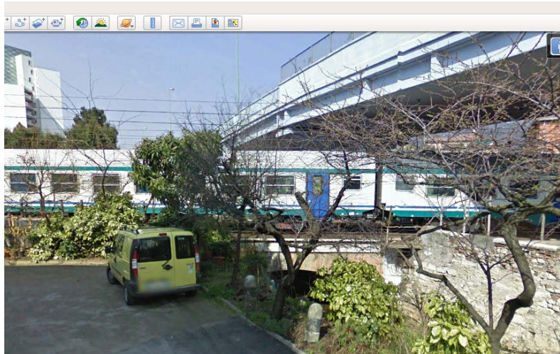
Figura 2: Attraversamento t. Garza attuale
