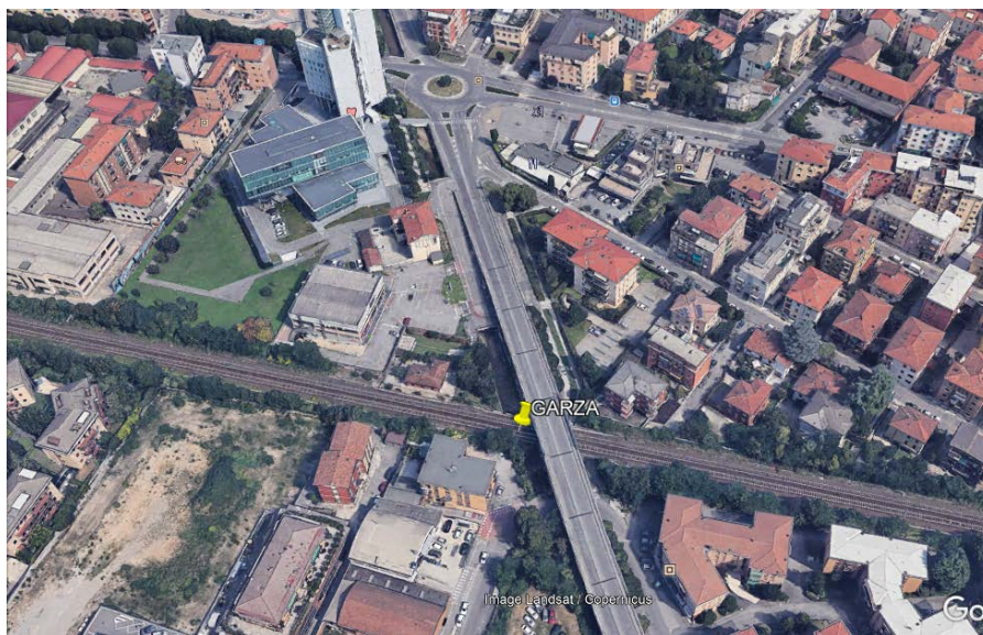
Figura 1: Attraversamento t. Garza
