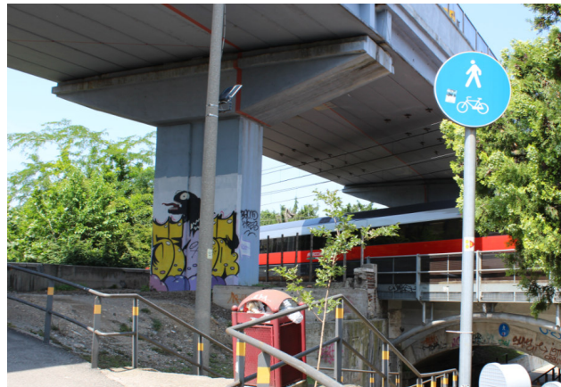
Sovrappasso esistente su via Kolbe
