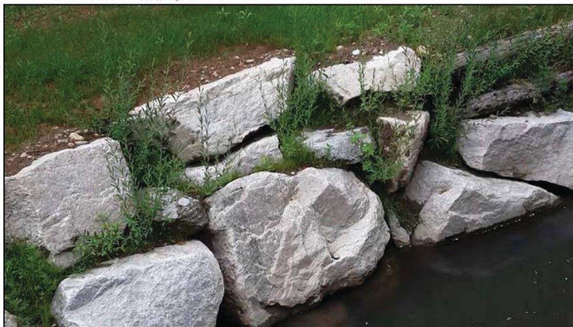
Figura 47 Sezione tipo e foto di scogliera con talee
