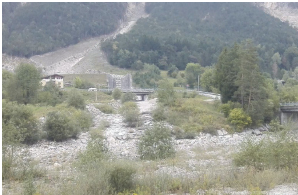
Figura 4.2-7 Rio Malborghetto a monte dell'impianto SRG. Si notino le sistemazioni dell'alveo e la briglia selettiva a chiusura dell'area di accumulo del trasporto solido
