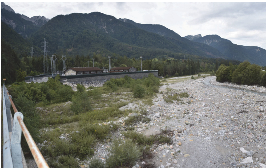
Figura 9.6-1 Vista delle sottostazioni elettriche dal ponte sul Fiume Fella
