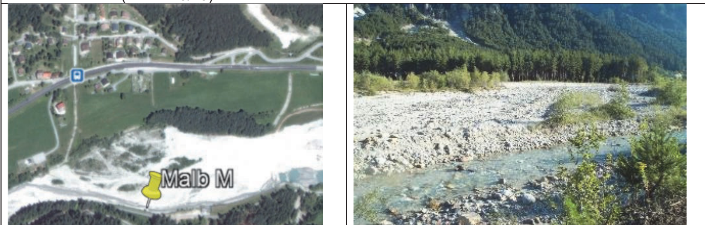
Figura 4.2-10 Stazione di monte
