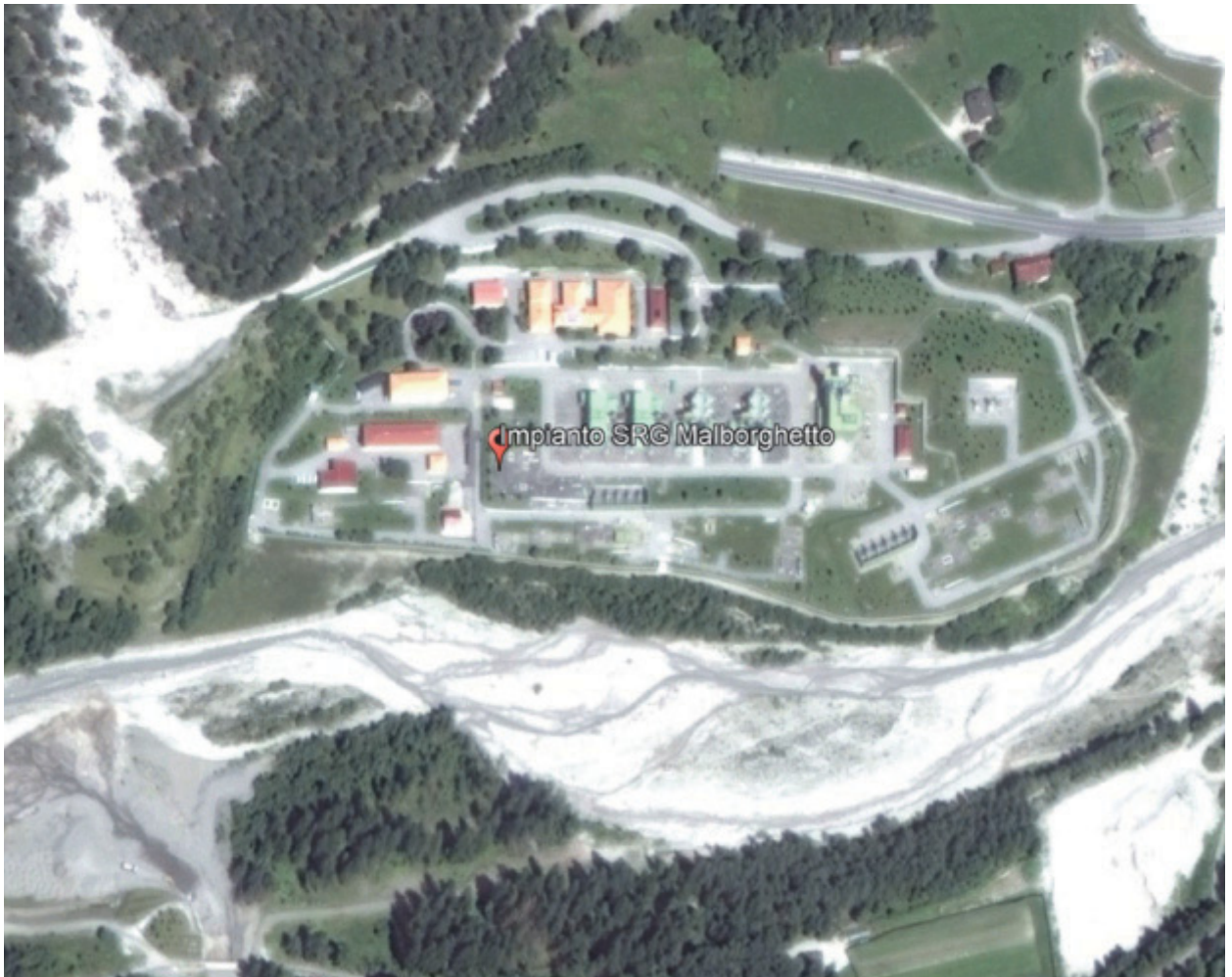
Figura 5.2-2 Immagine satellitare dell'impianto SRG di Malborghetto
