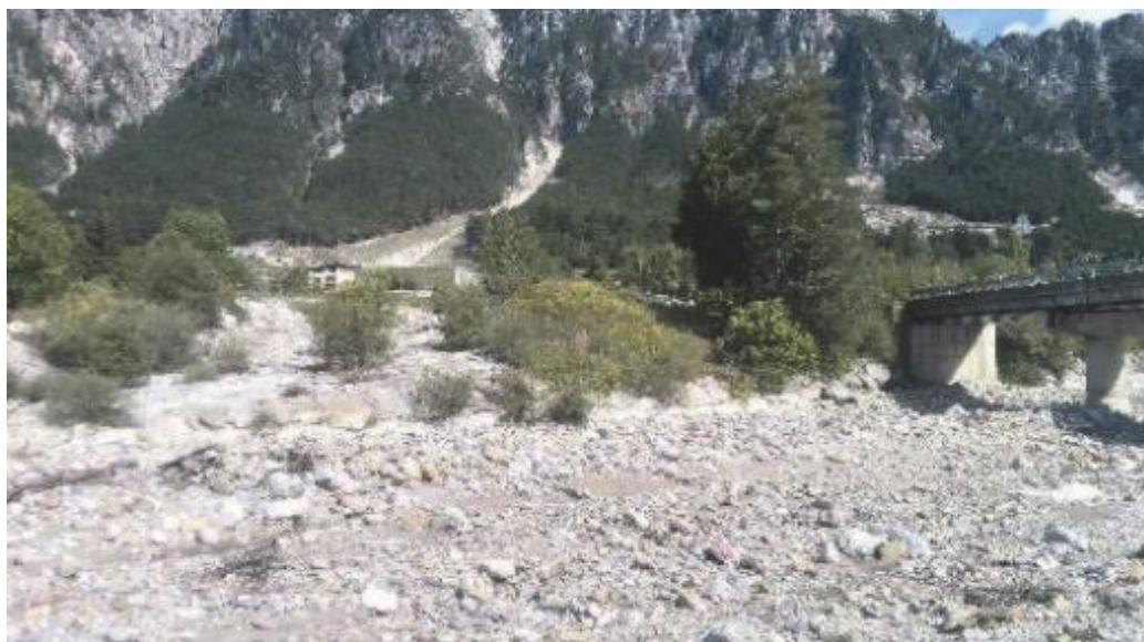
Figura 4.2-6 Opere di regimazione fluviale in sponda destra con la deviazione del rio a valle del ponte della strada secondaria
