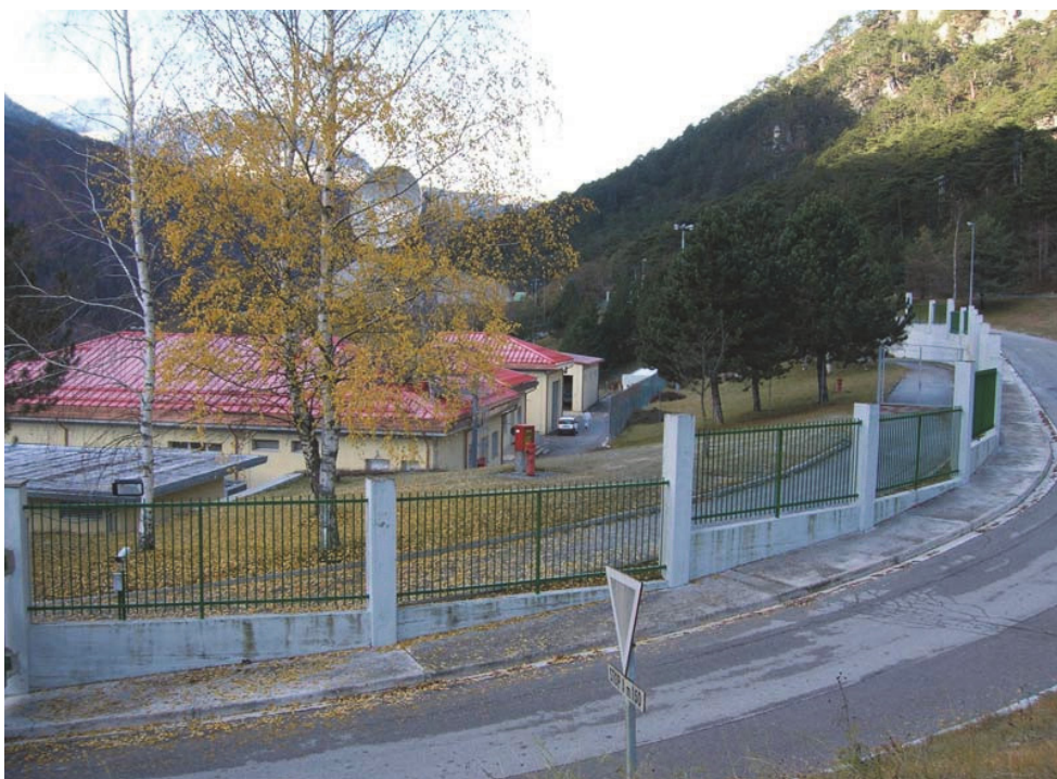
Figura 9.2-2 Vista degli edifici dell'impianto di compressione gas, dalla S.S. 13 – Pontebba
