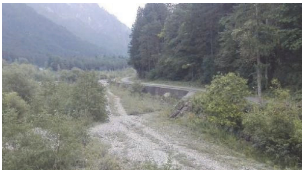
Figura 4.2-5 Opere di regimazione fluviale in sponda sinistra a monte del ponte
