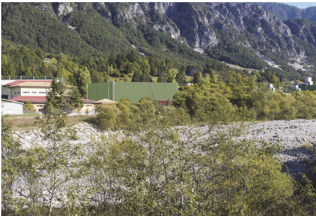
Figura 9.6-5 Vista dell'impianto compressione Gas dalla sponda in sinistra idrografica del Fiume Fella
