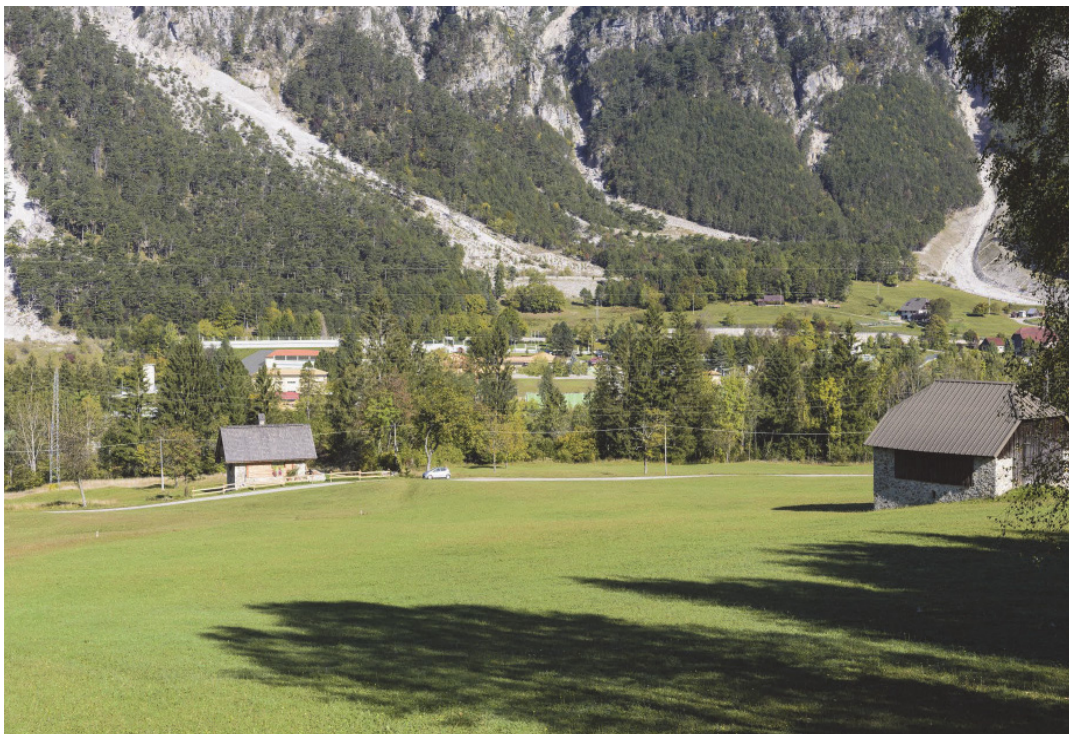
Figura 9.6-6 Vista dell'impianto compressione Gas dalla piazzola Autostradale A23
