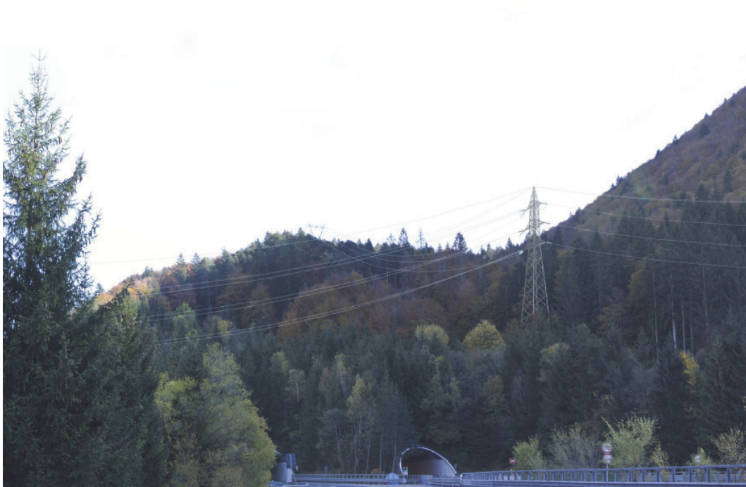
Figura 9.6-3 Vista del nuovo elettrodotto dalla piazzola di sosta dell'Autostrada A23
