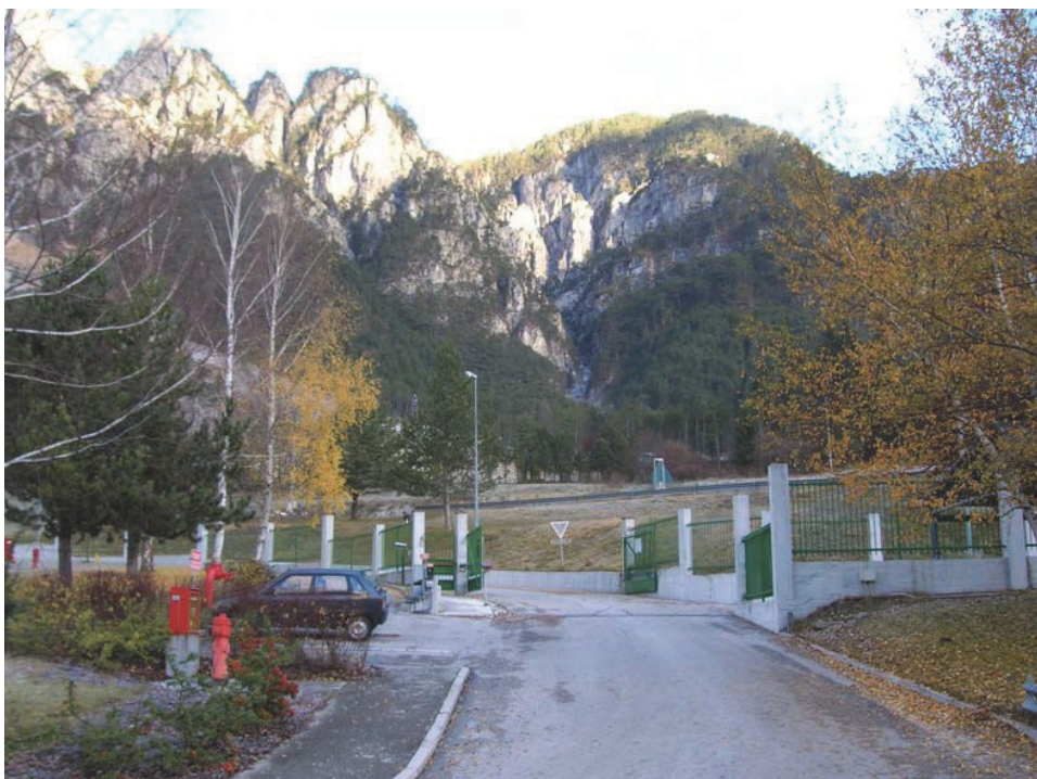
Figura 9.2-5 Vista dal versante Nord: panoramica del fondovalle e dell'area di impianto
