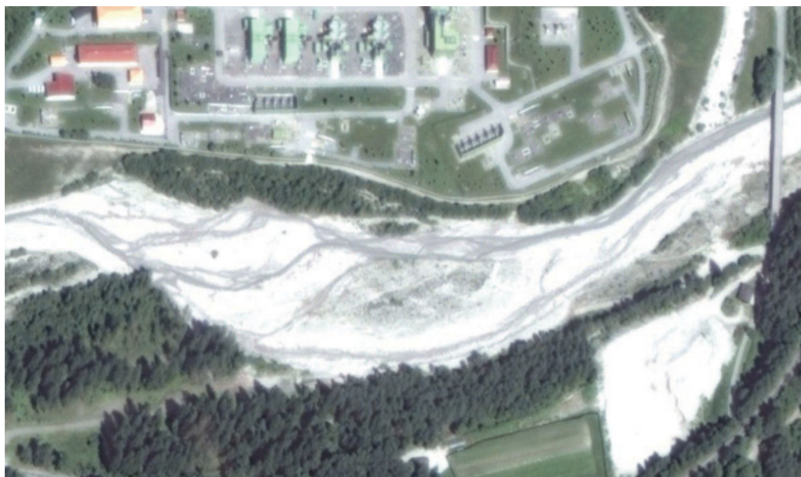
Figura 4.2-1 Andamento a canali intrecciati tipo Braided del f. Fella all'altezza dell'impianto Snam Rete Gas.
