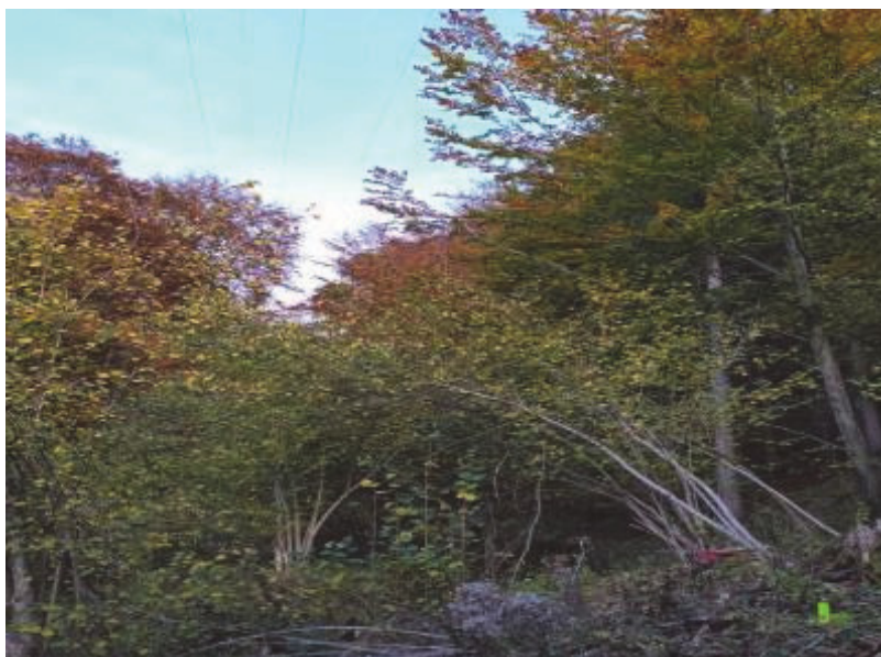
Foto 6.2-2 Linea 132 kV Chiusaforte - Tarvisio esistente sopra micro cantiere per il nuovo sostegno n. 3/1.
