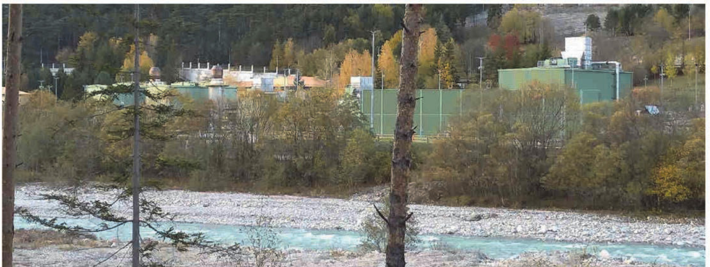
Fig.3 – Vista centrale Snam con diversi camini delle caldaie e cabine dei turbocompressori
