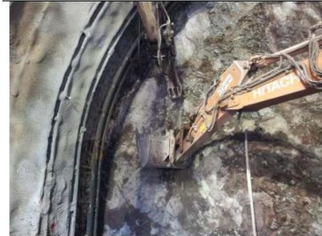
**Figura 20: esempio del prelievo di un incremento dal fronte di scavo.**
