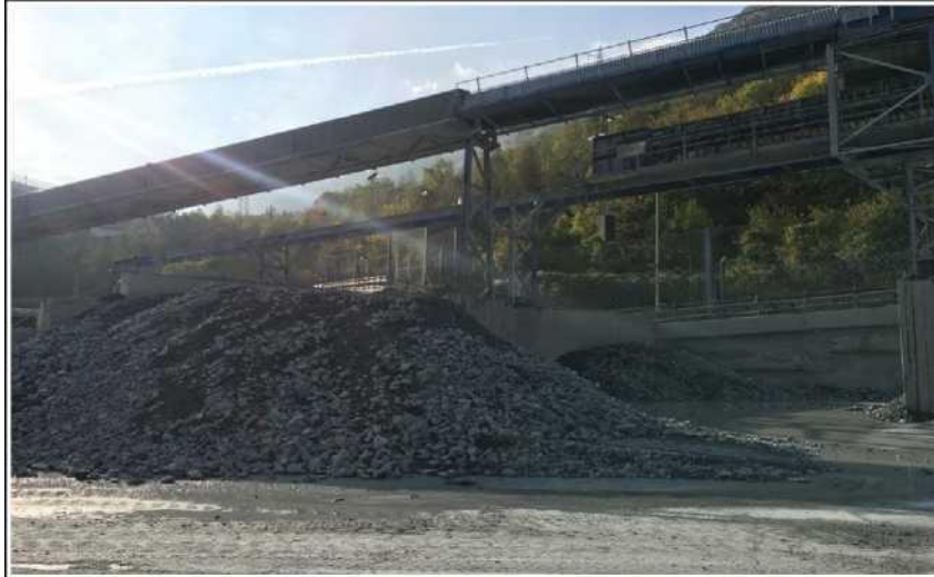
Figura 4: Materiale accantonato temporaneamente nell'area esterna del cantiere
