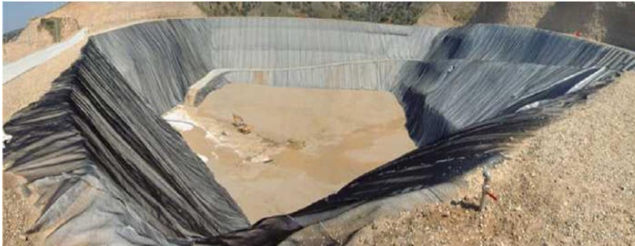
Figura 3: Esempio di utilizzo di una geomembrana
