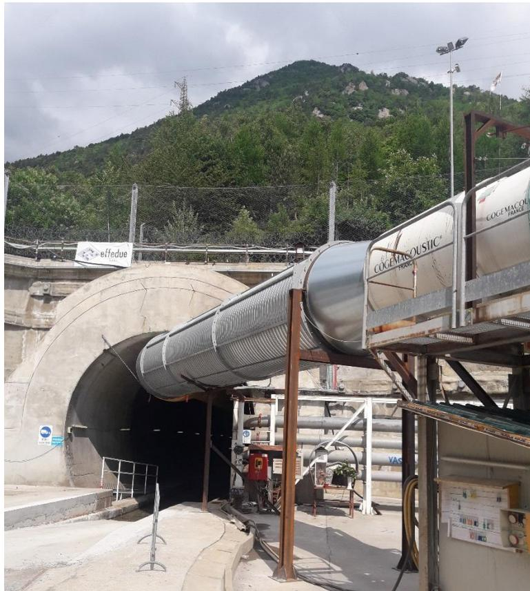
Figura 15 - ventilatore assiale presente in cantiere e tubazione in acciaio fino all'innesto in galleria
