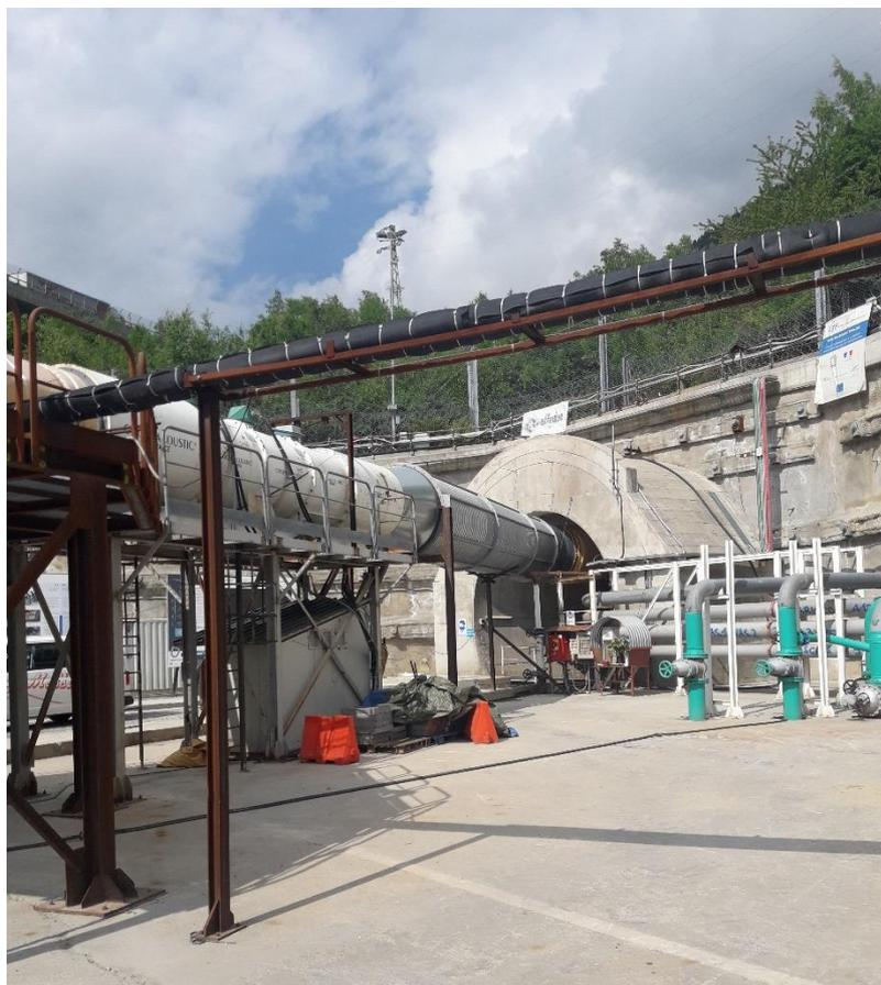
Figura 16 - ventilatore assiale presente in cantiere
