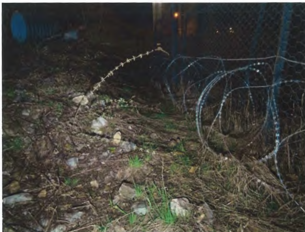
Figura 3-83: monitoraggio dell'estremità est dell'area di cantiere
