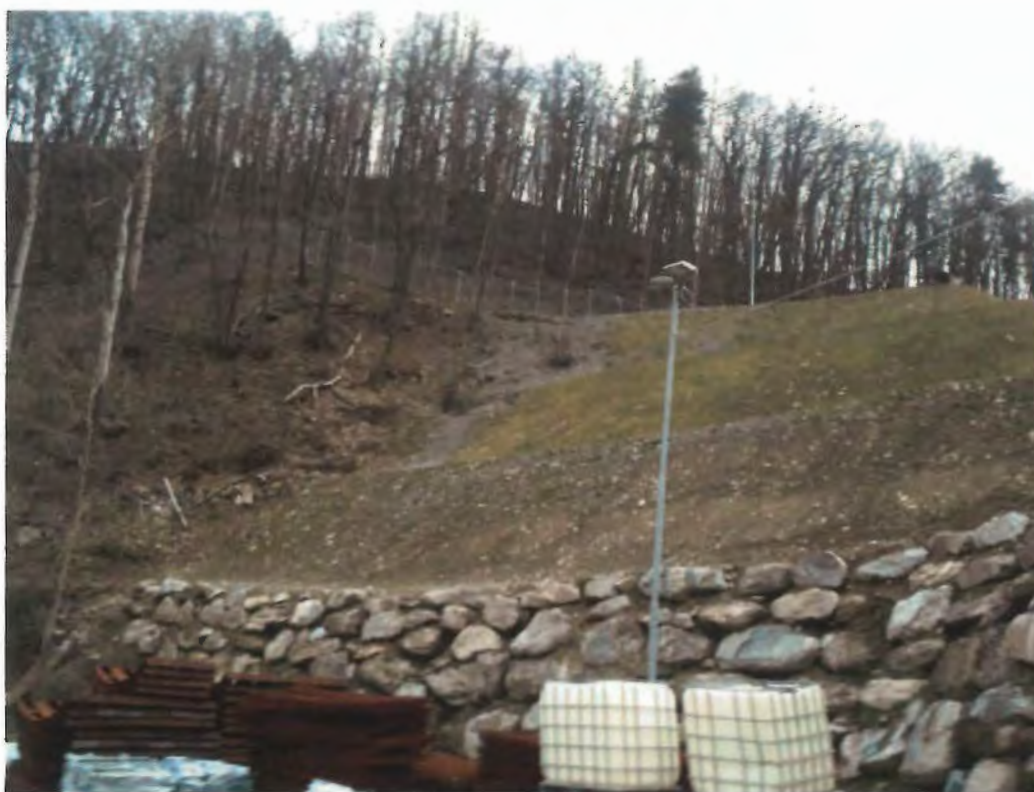
Figura 3-73: area meridionale del cantiere, oltre il sottopassaggio (primavera 2015).
