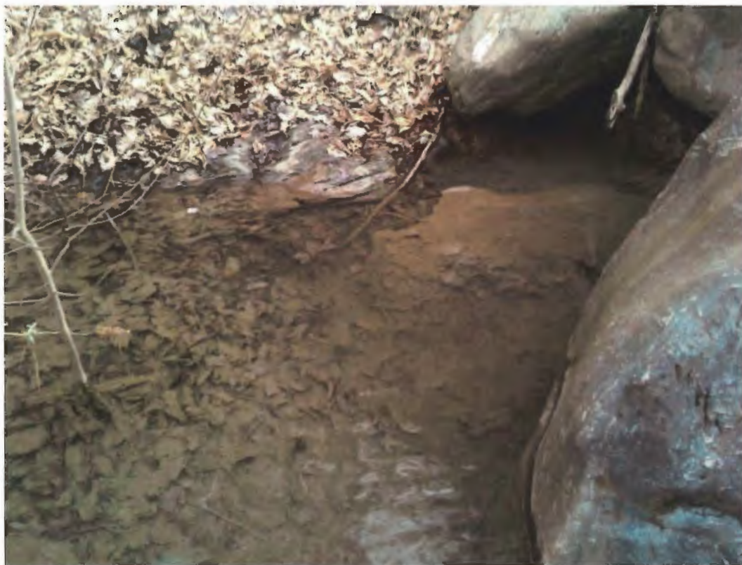
Figura 3-56: pozze d'acqua in corrispondenza del manufatto-primavera 2014.
