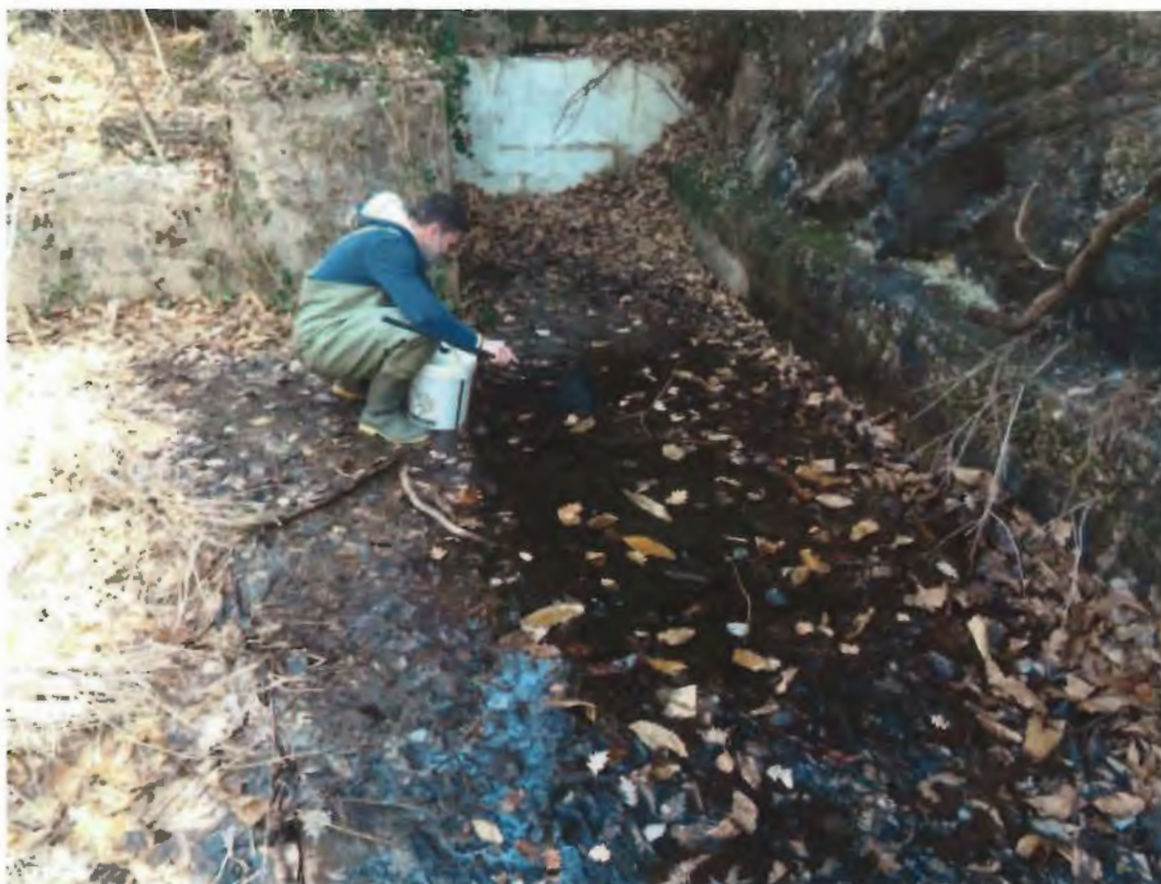
Figura 3-62: zona in corrispondenza del manufatto in disuso, in condizioni idonee ad ospitare fauna anfibia. Marzo 2018.
