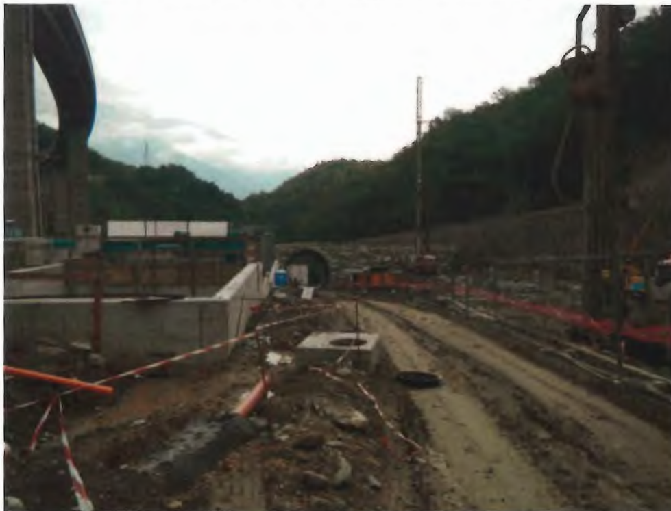
Figura 3-65: primavera 2013 - situazione dell'area di cantiere dove era presente l'impluvio colonizzabile dalla fauna anfibia in fase di AO.
