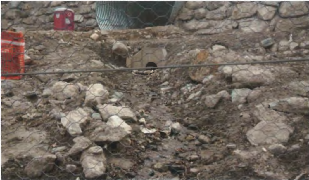
Figura 3-40: zona di uscita dell'impiuvio dalla zona di cantiere- primavera 2014.
