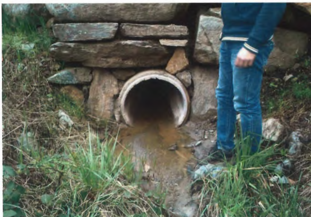
Figura 3-47: zona di uscita dell'impluvio dalla zona di cantiere. Marzo 2017. Si nota che l'ambiente è minimale e utilizzabile solo illimitatamente alla presenza di acque di scolo stagnanti nella tubazione.
