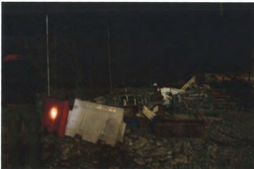
Figura 3-77: monitoraggio dell'estremità est dell'area di cantiere
