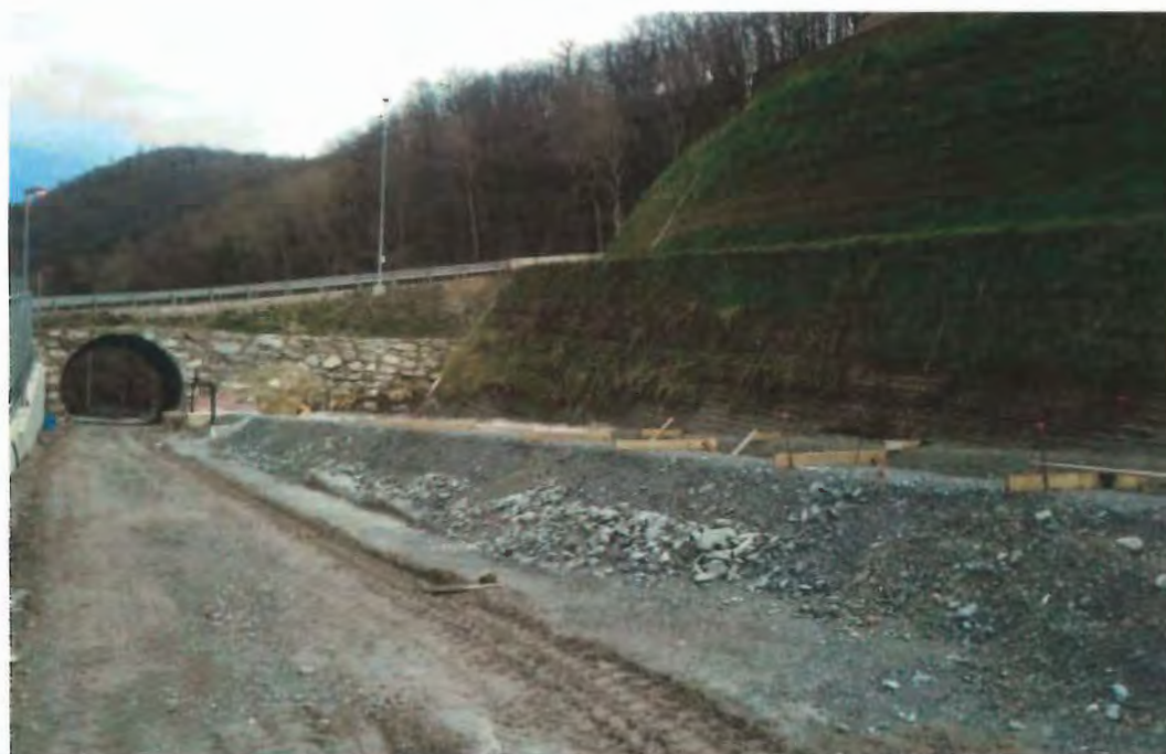
Figura 3-72: area meridionale del cantiere, che si estende fino oltre il sottopassaggio. Si nota come il versante sia isolato dal cantiere per la presenza del cumulo (primavera 2015).
