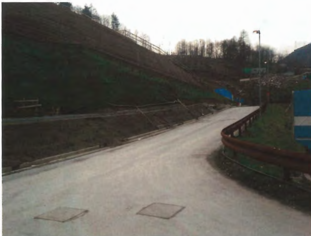
Figura 3-71: area di cantiere con versante avanzato dall'accumulo dello smarino (primavera 2015).
