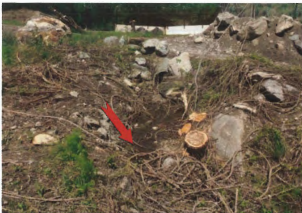
Figura 3-34: impluvio all'interno dell'area di cantiere in zona già soggetta a disboscamento e movimento terra-estate 2012.
