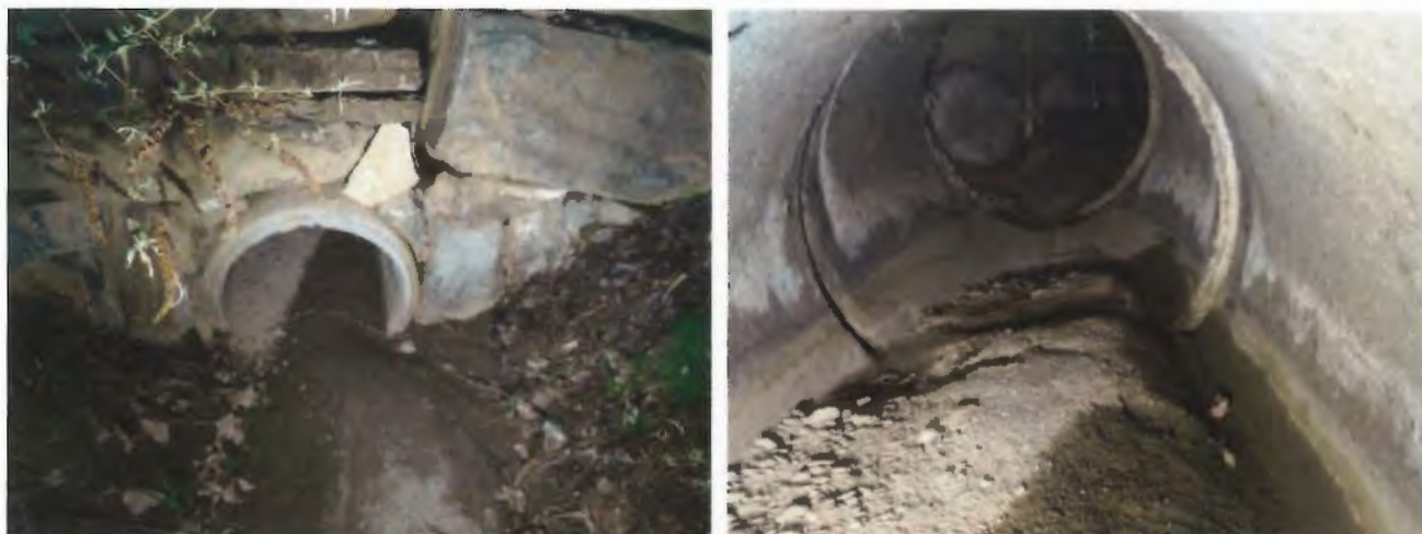
Figura 3-50: zona di uscita dell'impiuvio dalla zona di cantiere. Marzo 2018. Si nota la completa asciutta e l'interrimento della tubazione
