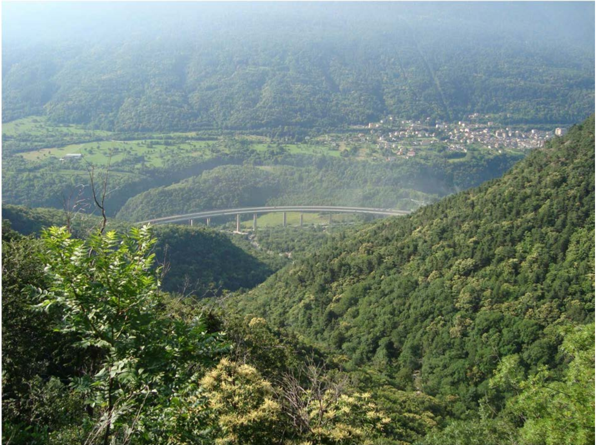
Figura 137 – Situazione ante operam
