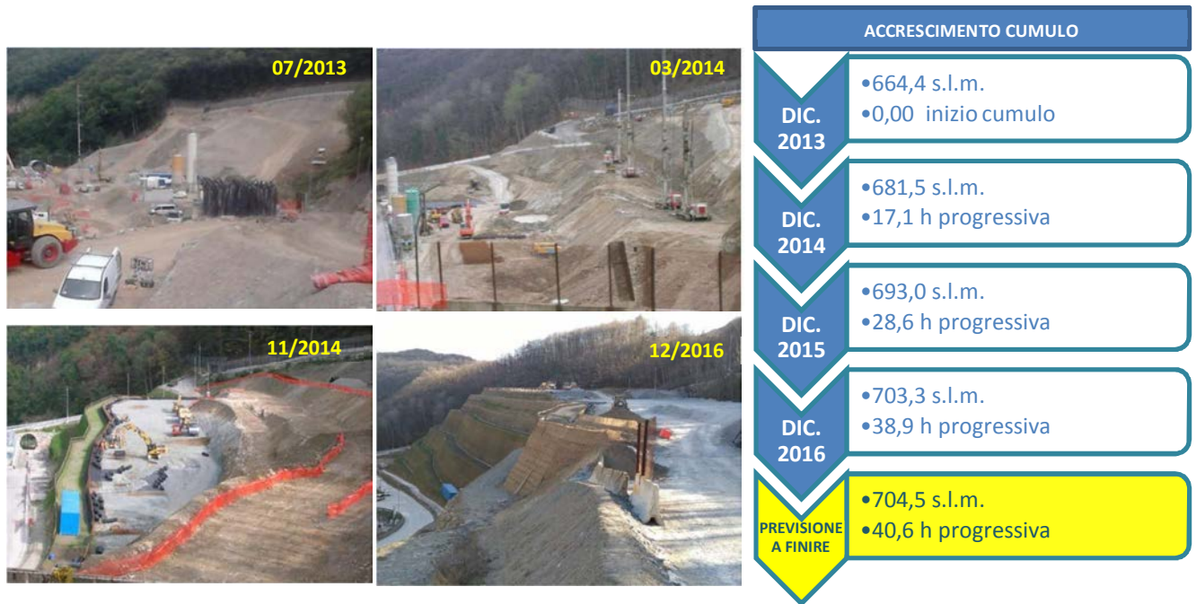
Figura 3 - Alcune fasi della realizzazione deposito definitivo
