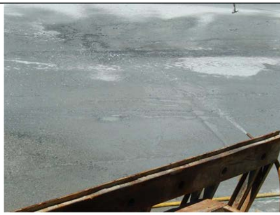
Figura 61 – Bagnatura dei piazzali
