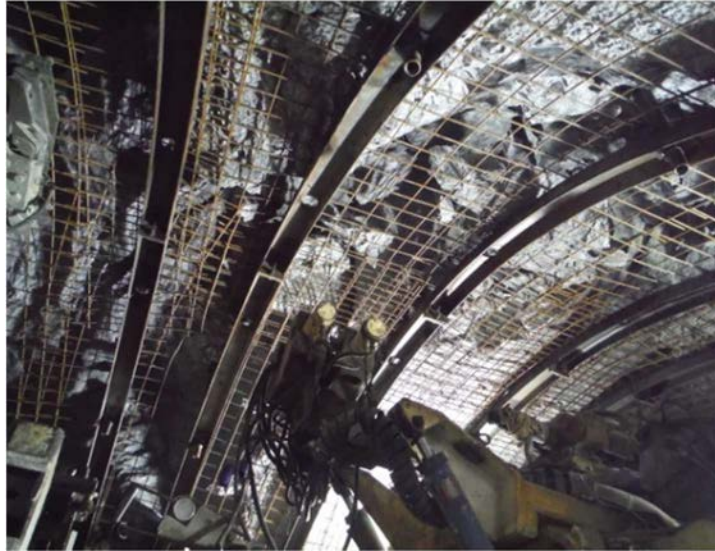
Figura 40 – Settore interessato da fenomeni di rilascio in calotta in cui è stato necessario mettere in opera centine e rete.
