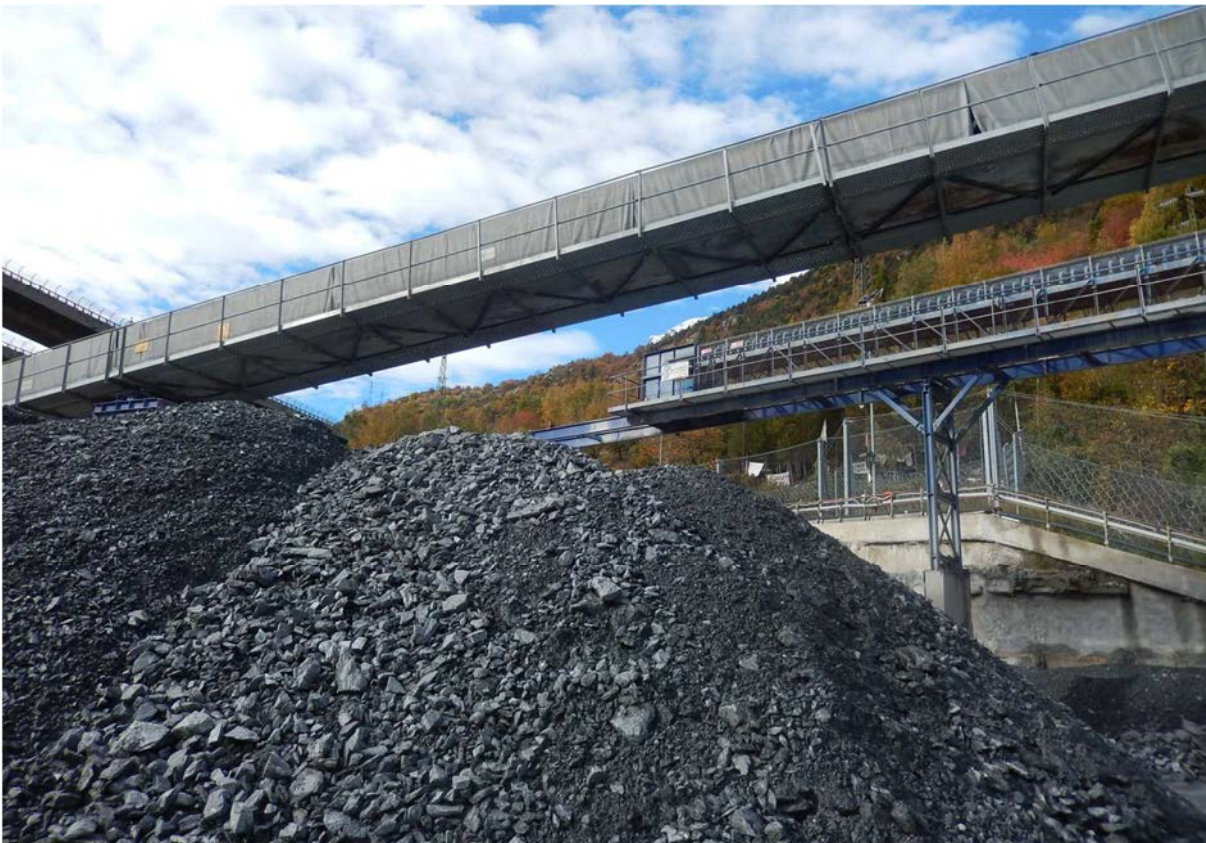
Figura 56 – Cumuli temporanei in cui il marino viene trasferito tramite nastri trasportatori chiusi
