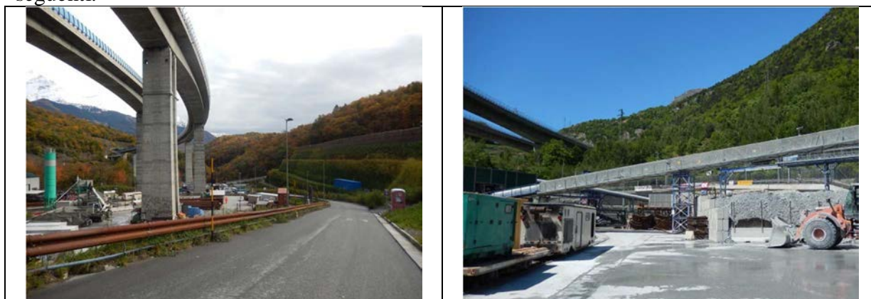
Figura 58 – Pavimentazione di viabilità e piazzali
