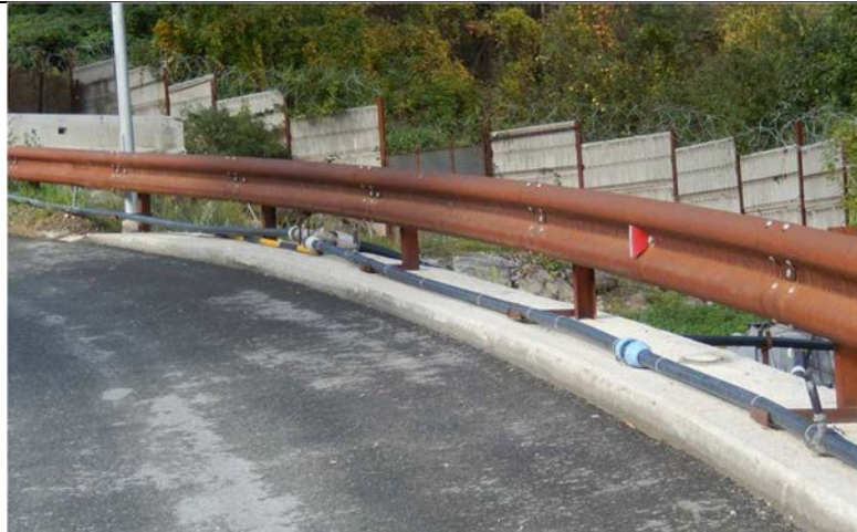
Figura 135 – Gard rail in acciaio corten
