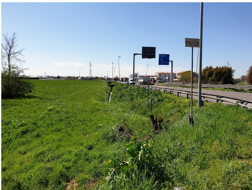
Figura 14 - Vista dell'area di futura realizzazione della "Controstrada"
