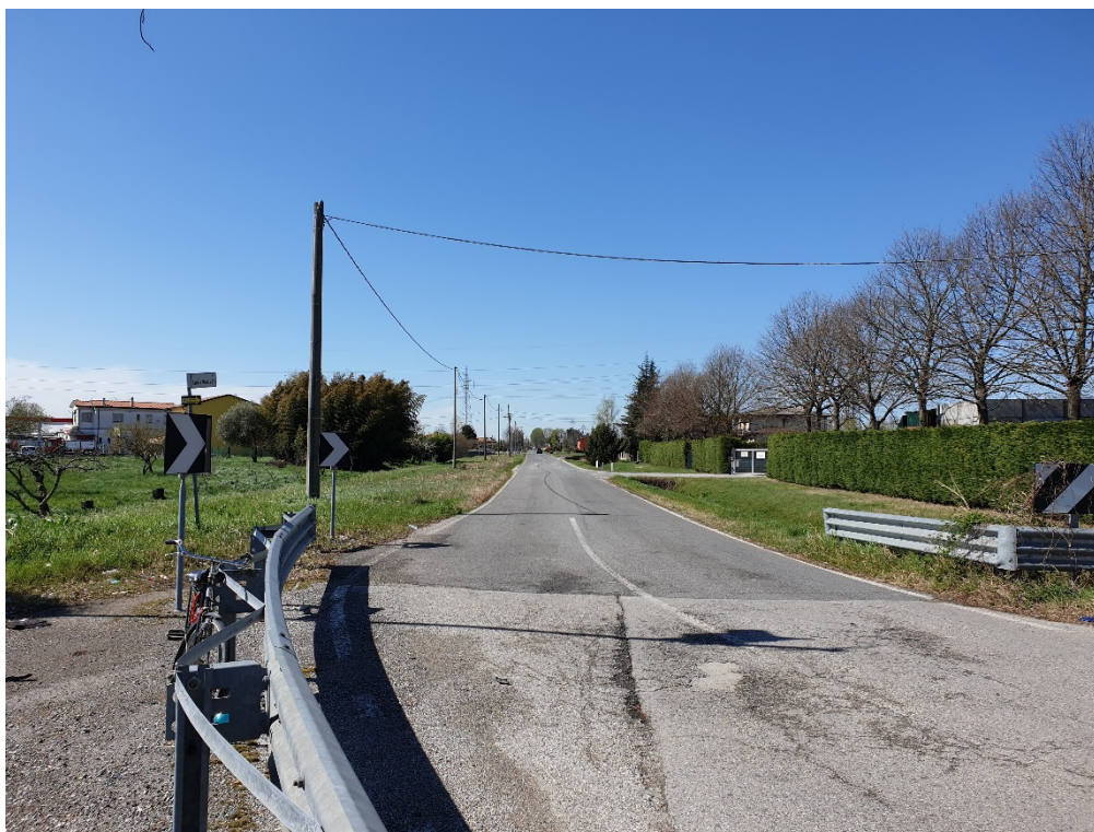
Figura 12 - Vista su Via Seriola Veneta Destra.
