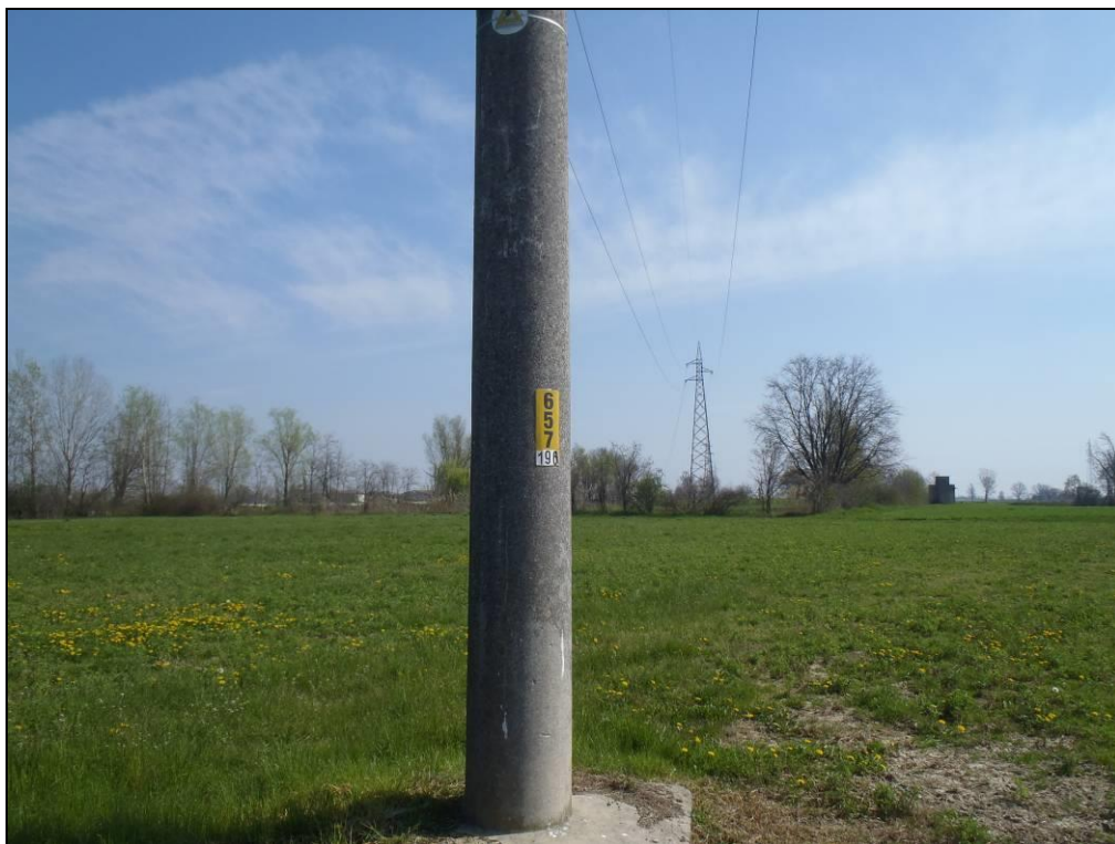
Campo nei pressi del sostegno 196.
