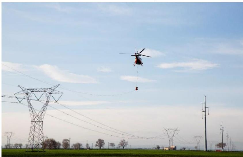
**Figura 3-12 Utilizzo dell'elicottero per la stesura della fune pilota**
