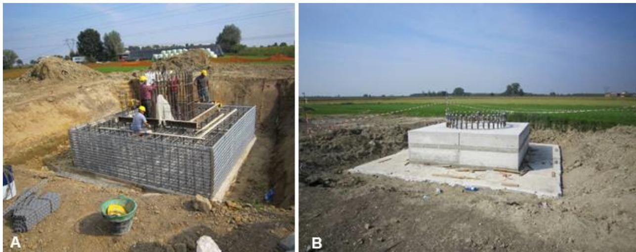
**Figura 3-7** *Fondazione superficiale tipo plinto a monoblocco per un sostegno monostelo. Fase di cassetatura. B. fondazione appena realizzata: flangia metallica dotata di tirafondi di raccordo con la parte in elevazione*
