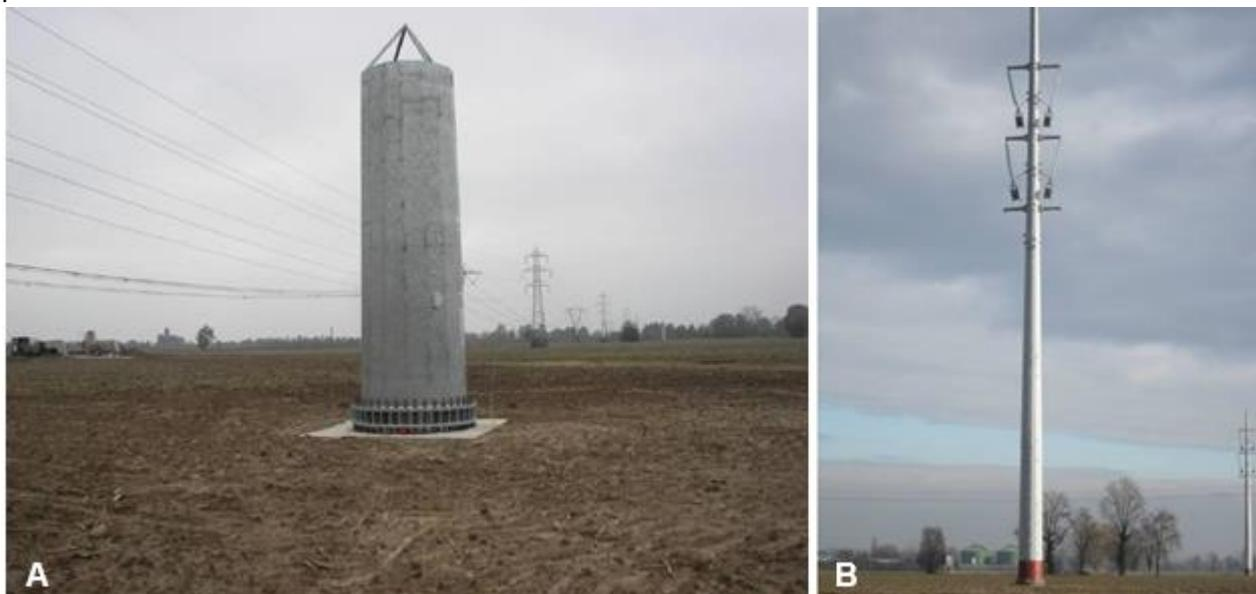
**Figura 3-8** *A. Realizzazione di fondazioni superficiali tipo plinto a monoblocco per un sostegno monostelo: esempio di fondazione completata e sistemazione del terreno nell'area circostante. B. Sostegno monostelo montato: carrucole collegate alle catene degli isolatori nella fase che precede la "tesatura" dei conduttori*
