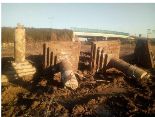
**Figura 3-22 Esempio di rimozione della fondazione superficiale di un sostegno a 220 kV**
