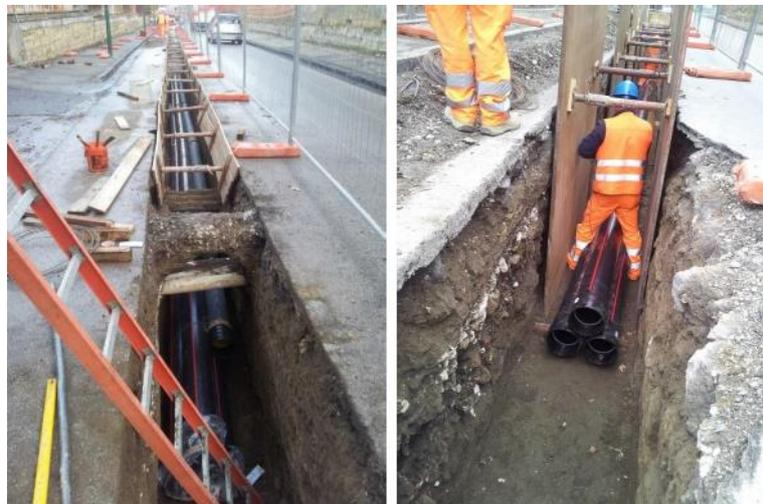
**Figura 3-15 Esempio di posa in tubiera con relative sbatacchiature eseguita su strada**
