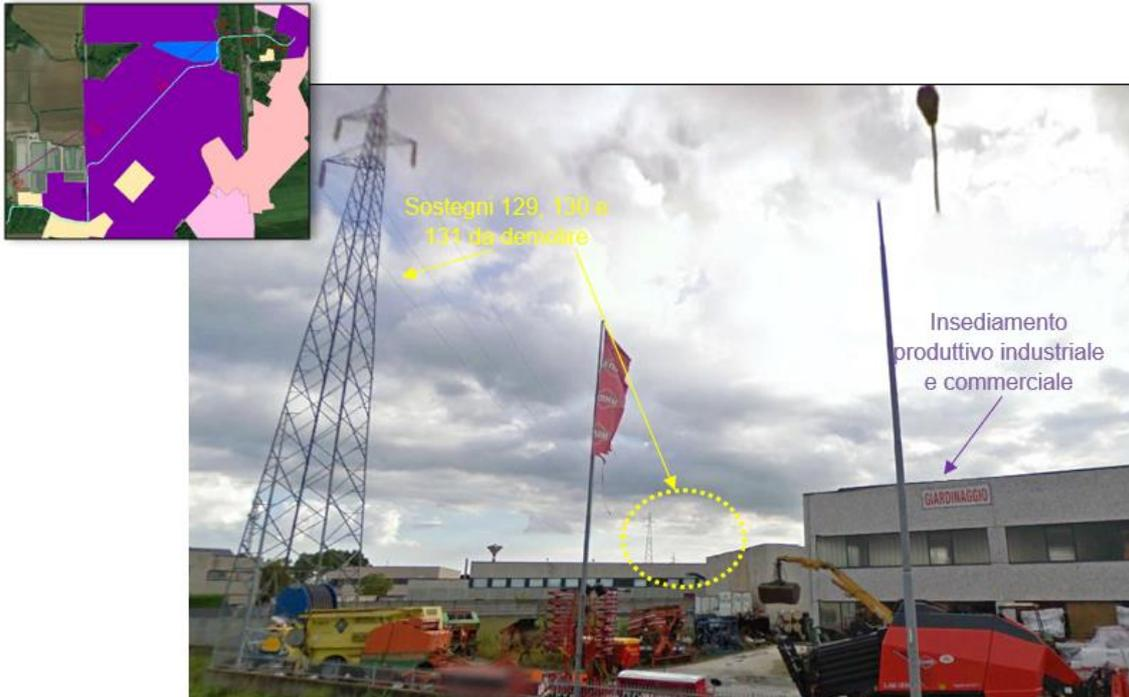
**Figura 4-21 Vista dalla SP2 in direzione degli esistenti sostegni 129, 130 e 131 oggetto di demolizione, che ricadono nell'insediamento produttivo industriale e commerciale, per tale tratto l'intervento della nuova linea T184 si prevede la realizzazione del cavo interrato.**
