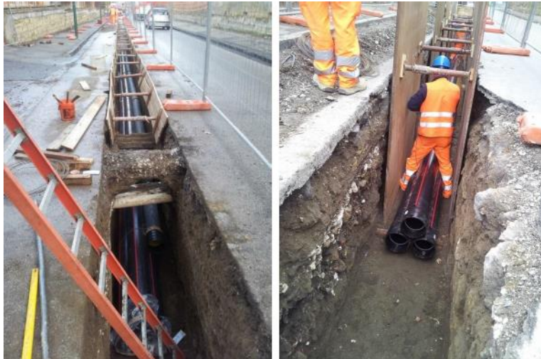
Figura 6-21 Esempio di posa in tubiera con relative sbatacchiature eseguita su strada
