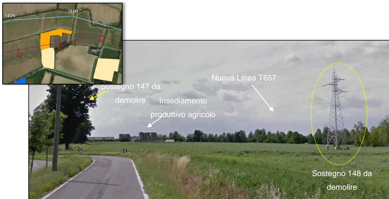
Figura 7-63 Vista da Via Roma in direzione dell'insediamento produttivo agricolo, nel comune di Gadesco – Pieve Delmona e allo stato attuale interferito dall'attraversamento della linea esistente; la nuova linea T657 verrà posta più a nord eliminando in tal modo tale interferenza.
