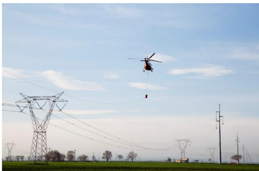
Figura 6-17 Utilizzo dell'elicottero per la stesura della fune pilota
