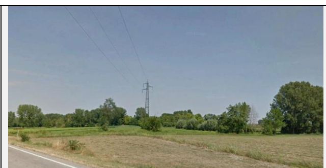
Figura 7-80 Vista del sostegno esistente, oggetto di demolizione, 92, e in direzione del nuovo sostegno 69N, presenti nell'ambito agricolo di elevata valenza paesaggistica.
