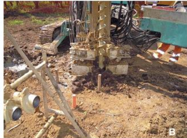
Figura 6-15 Fondazioni con micropali tubifiz. A. Disegno costruttivo di un micropalo. B. Macchina operatrice per la realizzazione di micropali tubifiz: sistema di scavo mediante trivella elicoidale
