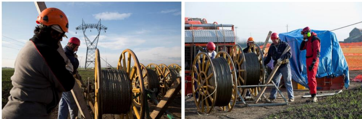
Figura 6-18 Fasi di tesatura della linea elettrica
