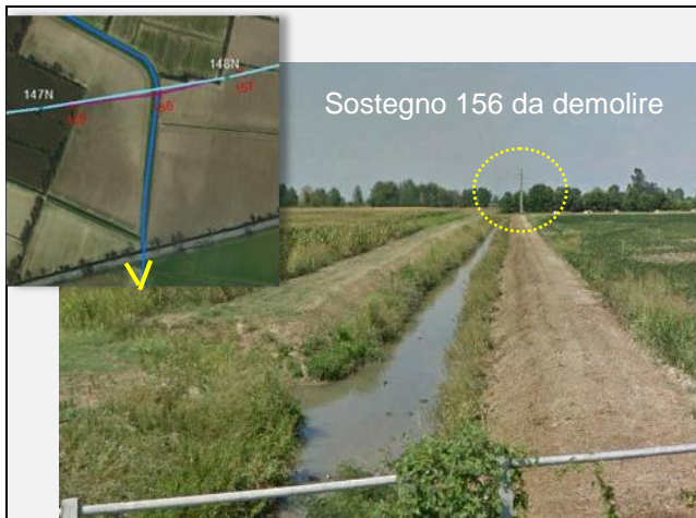
Figura 7-77 Vista del Naviglio Dugale Delmona in direzione del sostegno 156 oggetto di demolizione.
