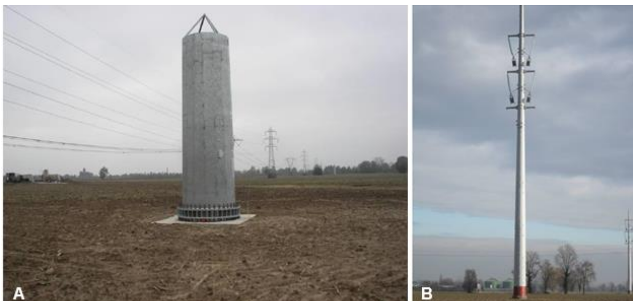
Figura 6-13 A. Realizzazione di fondazioni superficiali tipo plinto a monoblocco per un sostegno monostelo: esempio di fondazione completata e sistemazione del terreno nell'area circostante. B. Sostegno monostelo montato: carrucole collegate alle catene degli isolatori nella fase che precede la "tesatura" dei conduttori
