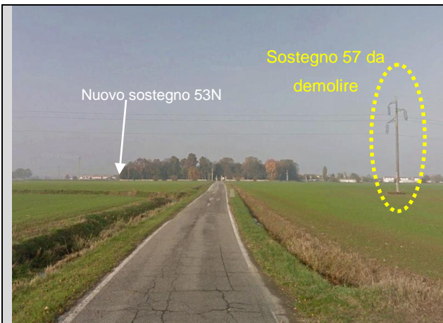
Figura 7-73 Vista da Via delle Barricate, ex viabilità storica.
