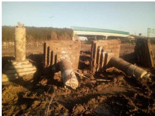
Figura 6-28 Esempio di rimozione della fondazione superficiale di un sostegno a 220 kV
