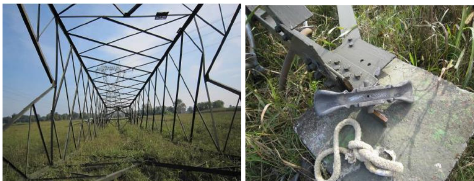
Figura 6-27 Fasi di smantellamento di un sostegno a traliccio
