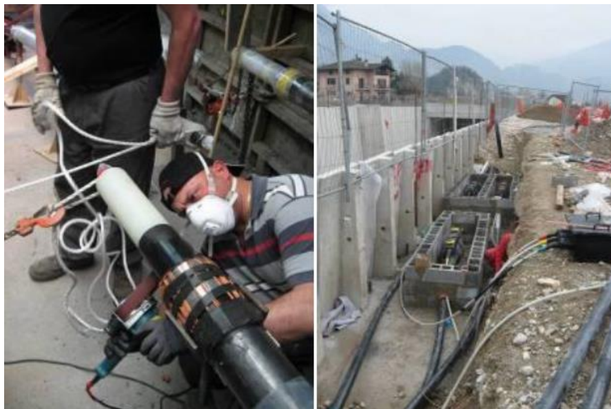
Figura 6-26 Esecuzioni giunti, esempio buca giunti
