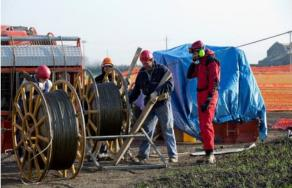
Figura 3-13 Fasi di tesatura della linea elettrica
