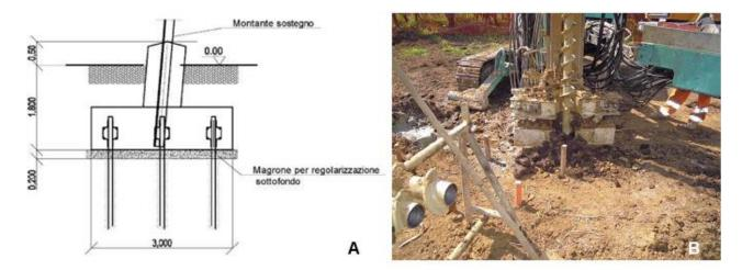
Figura 3-10 Fondazioni con micropali tubifiz. A.Disegno costruttivo di un micropalo. B. Macchina operatrice per la realizzazione di micropali tubfix: sistema di scavo mediante trivella elicoidale
