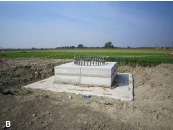
Figura 3-7 Fondazione superficiale tipo plinto a monoblocco per un sostegno monostelo.
