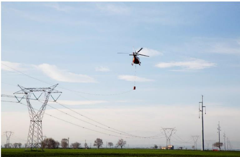
Figura 4-12 Utilizzo dell'elicottero per la stesura della fune pilota
