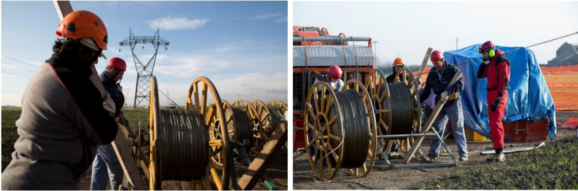
Figura 4-13 Fasi di tesatura della linea elettrica
