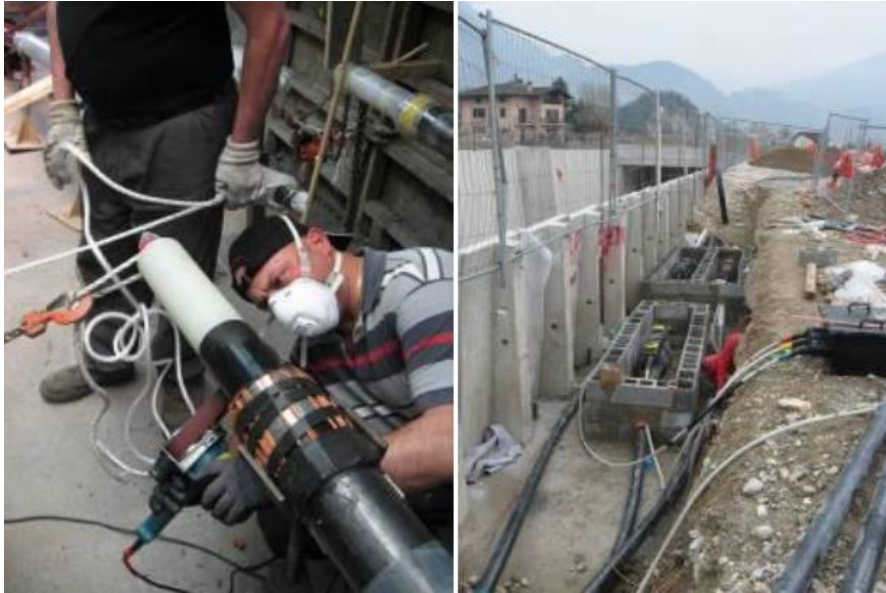
Figura 4-20 Esecuzioni giunti, esempio buca giunti
