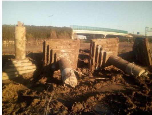
Figura 4-22 Esempio di rimozione della fondazione superficiale di un sostegno a 220 kV
