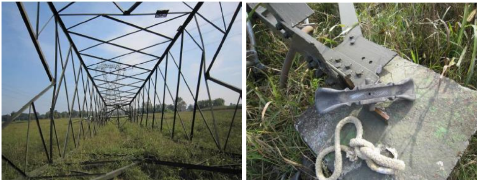
Figura 4-21 Fasi di smantellamento di un sostegno a traliccio
