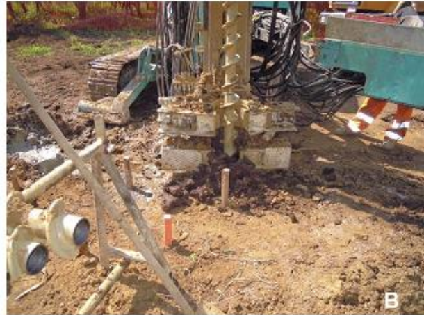
Figura 4-10 Fondazioni con micropali tubifiz. A. Disegno costruttivo di un micropalo. B. Macchina operatrice per la realizzazione di micropali tubifiz: sistema di scavo mediante trivella elicoidale
