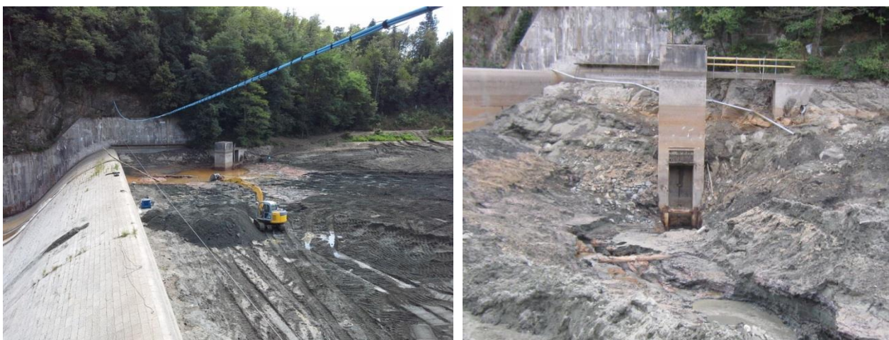
Figura 17 – Anno 2015: inizio degli scavi a terno dello scarico di fondo e struttura dello scarico liberata dai sedimenti.
