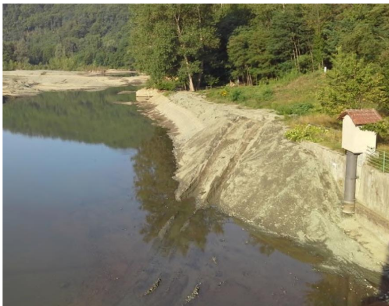
Figura 14 – Rampa di accesso in alveo utilizzata per gli interventi passati.
