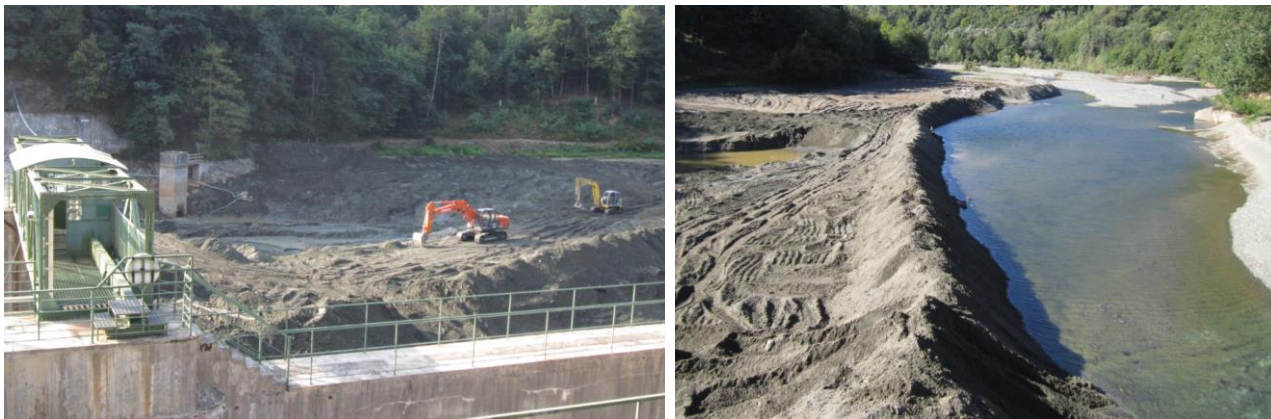
Figura 16 – Anno 2015: attività di scavo e tura provvisoria.
