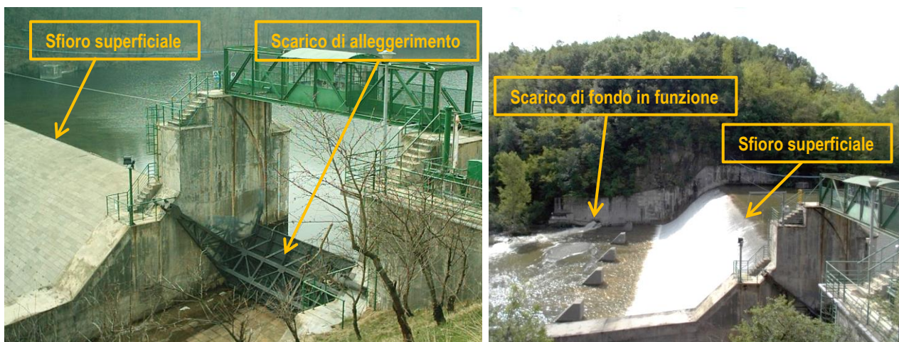
Figura 2 - Sx: sfioratore superficiale e scarico di alleggerimento; dx: diga di Ortiglieto con scarichi di fondo e superficiale in funzione.
