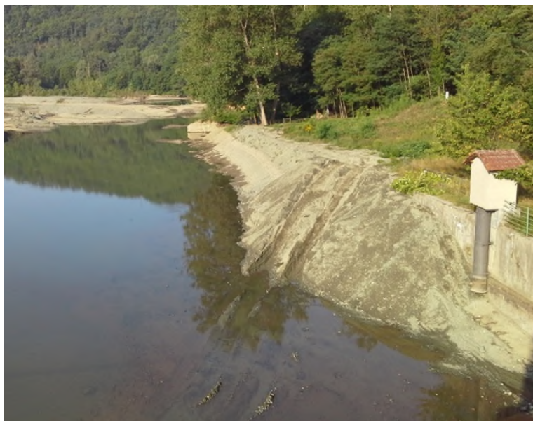
Figura 9: rampa di accesso all'alveo eseguita per gli interventi passati.
