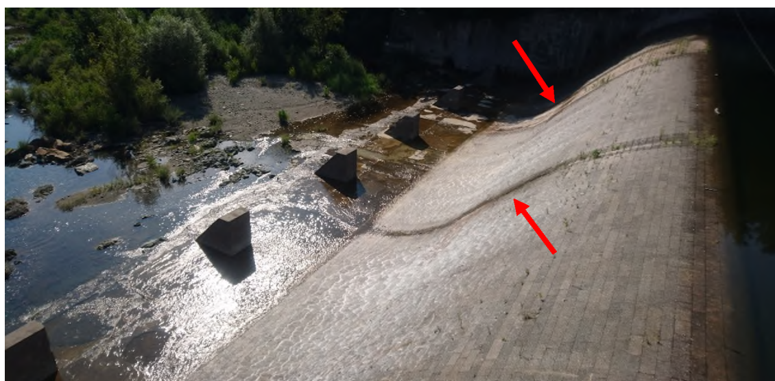
Figura 4: vista del paramento di valle e individuazione dei giunti di dilatazione.
