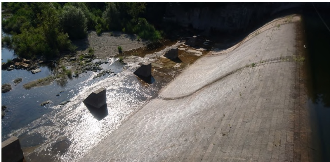
Figura 7: vista del paramento di valle e dei bolognini.
