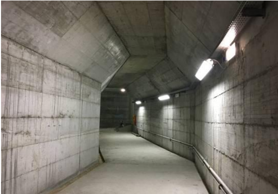
Figura 11 - galleria di collegamento tra camere di manovra
