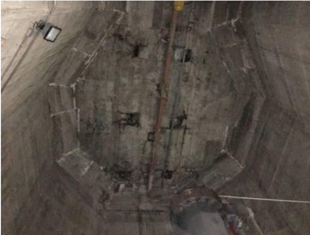
Figura 13 - Camera di manovra vecchie paratoie - particolare intradosso copertura
