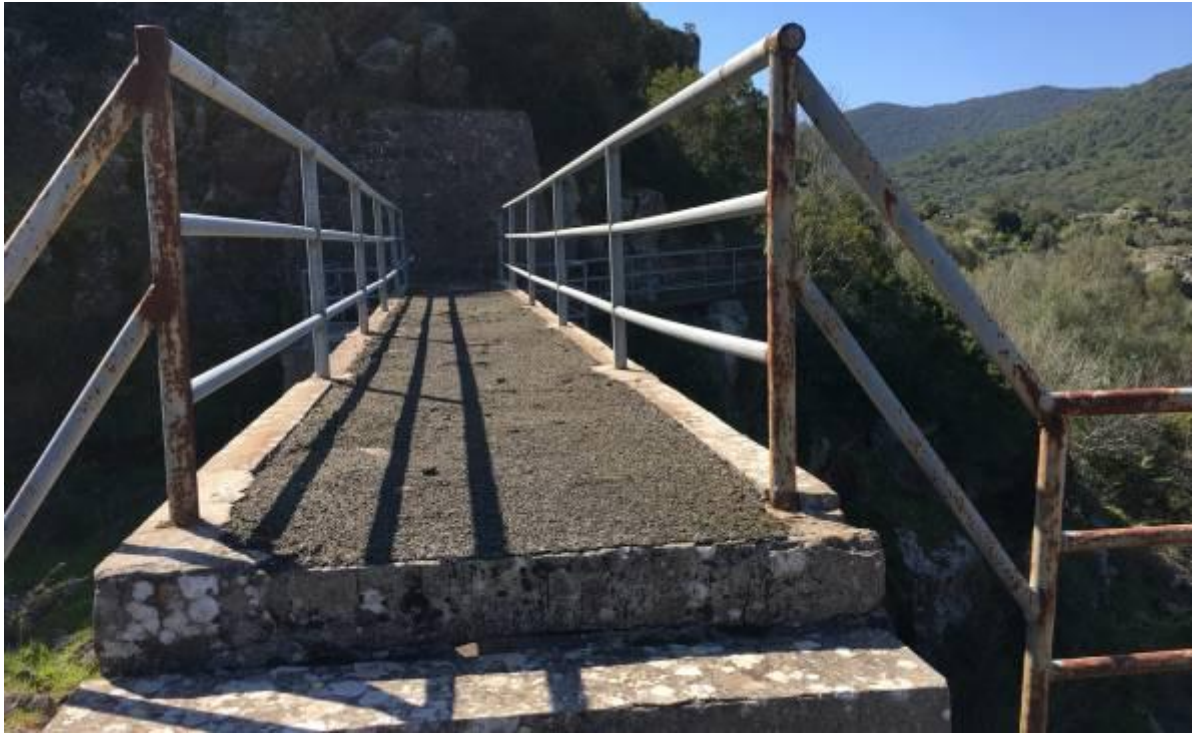
Figura 7 - Coronamento - passerella pedonale sullo scarico di superficie
