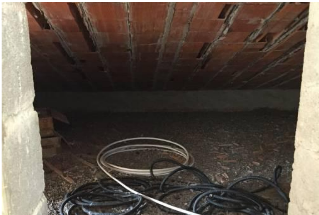
Figura 18 - Locale sottotetto - in evidenza lo stato della copertura
