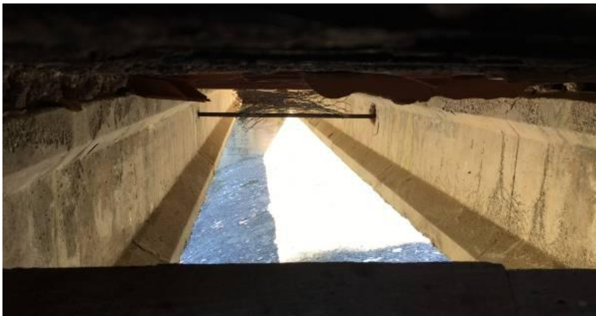
Figura 8 - Coronamento - passerella pedonale: dettaglio intradosso
