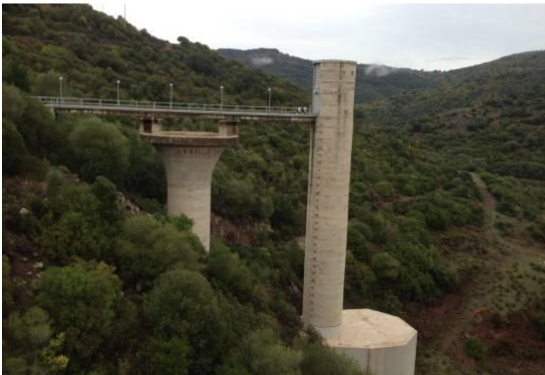
Figura 2 - scarico di troppo pieno e torre di accesso alla camera di manovra e alla galleria di collegamento
