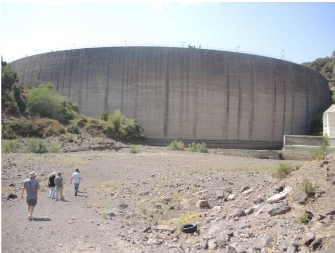
Figura 9 - Area interessata dalla rimozione dei sedimenti
