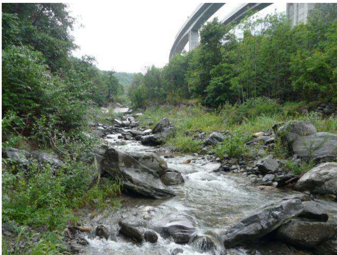
Figura 3-8: stazione di valle del T. Clarea
