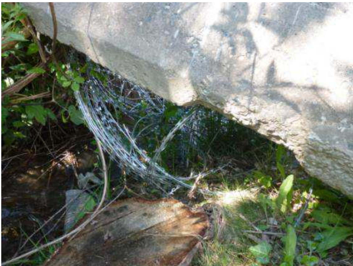
Figura 3-51: passaggio del piccolo ruscello al di sotto delle barriere di protezione del cantiere
