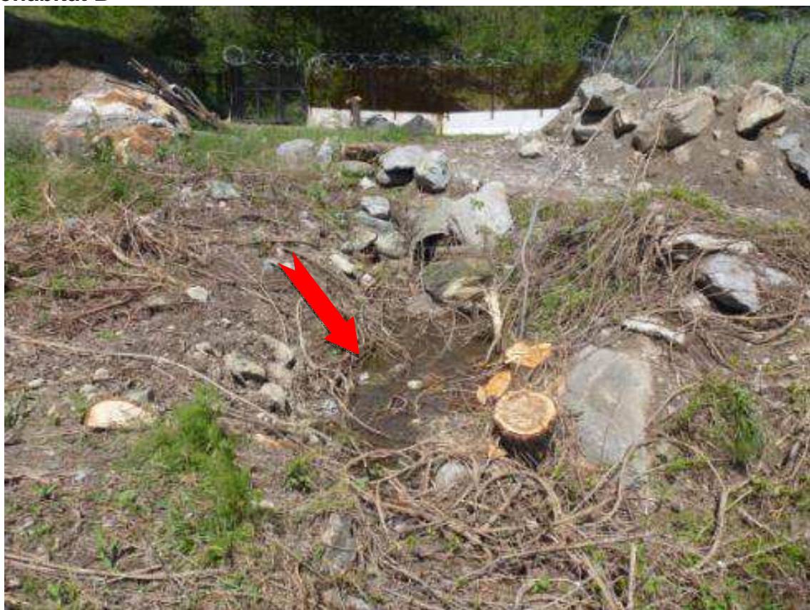
Figura 3-50: impluvio in area di cantiere in zona già soggetta a disboscamento e movimento terra
