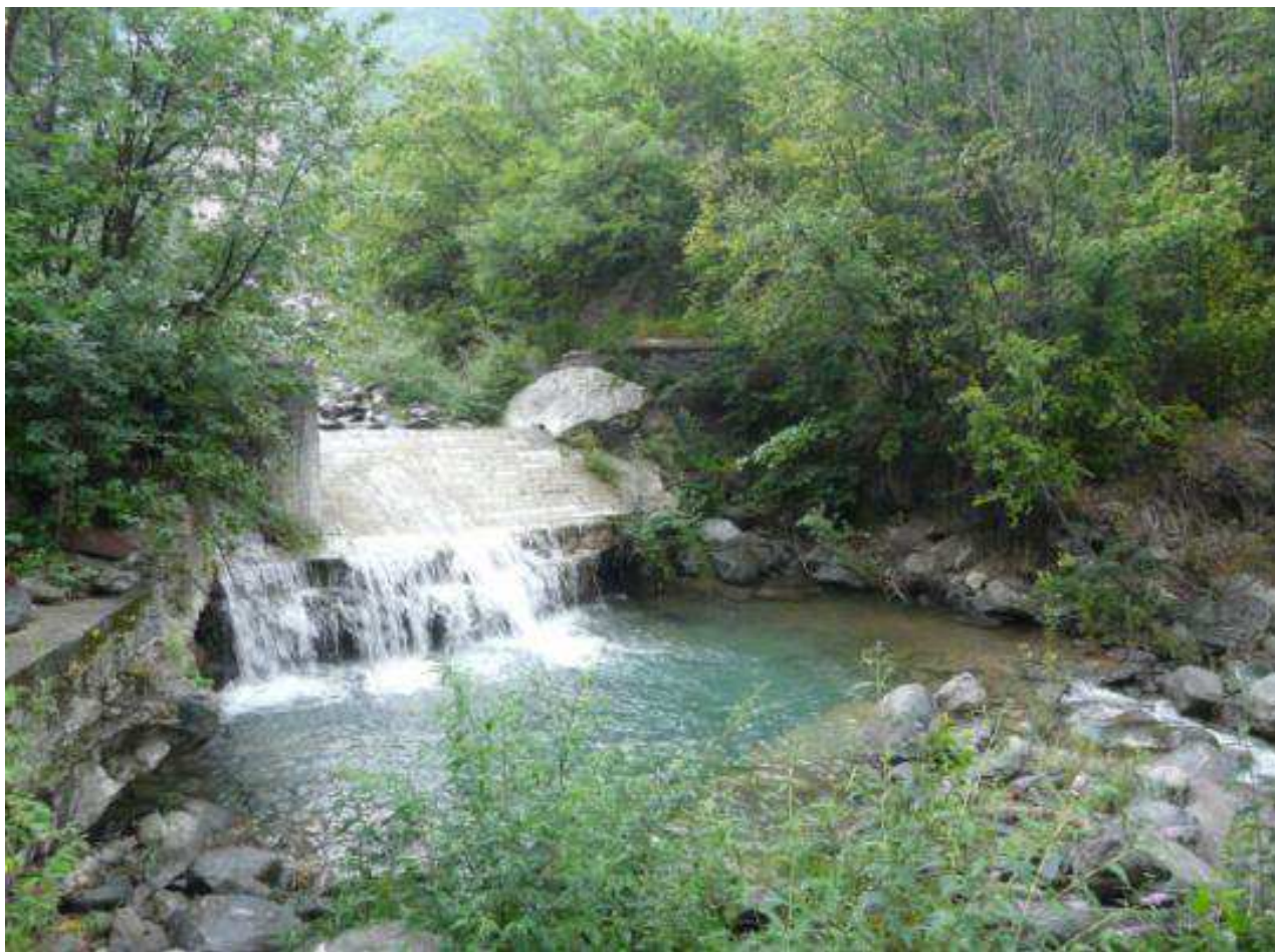
Figura 3-33: porzione posta più a monte del tratto di valle dove è presente un manufatto di derivazione seguito da una pool
