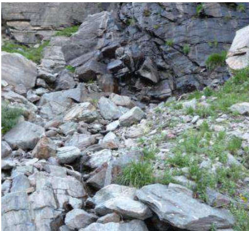
Figura 3-10: visione d'insieme del tratto campionato, si nota l'elevata pendenza e le infiltrazioni di acque provenienti dal versante
