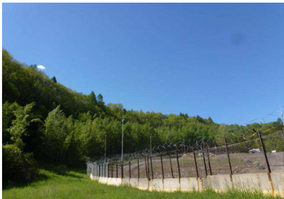
Figura 3-39 - Ubicazione del punto RAN03 nei pressi della recinzione.
