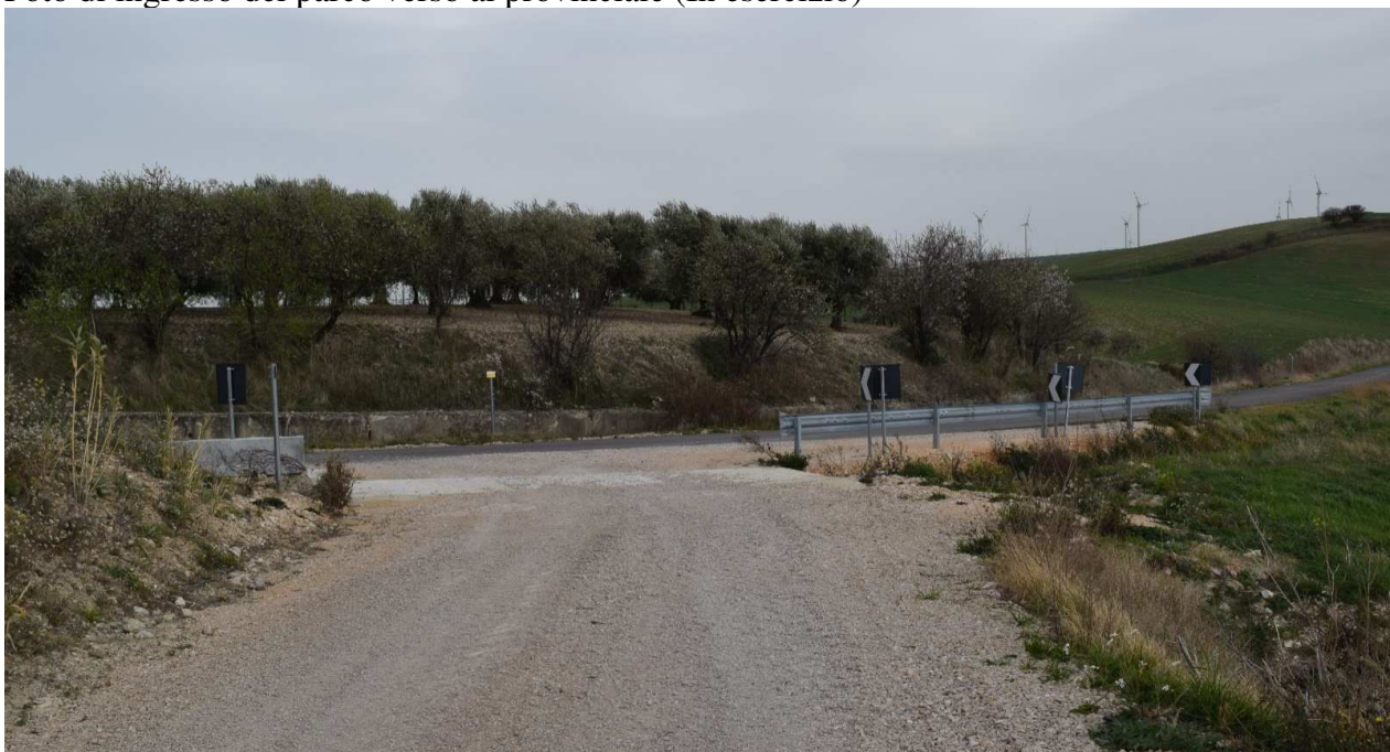
Foto di ingresso del parco verso al provinciale (In esercizio)
