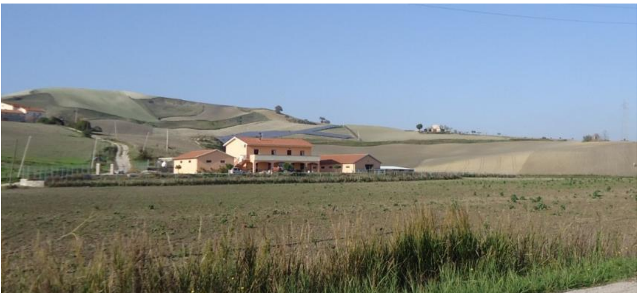
Figura 5.l: Guglionesi – Impianto Fotovoltaico
