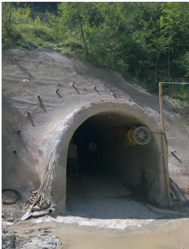
Fig. 5.2/C –Esempio fase di consolidamento galleria di base
