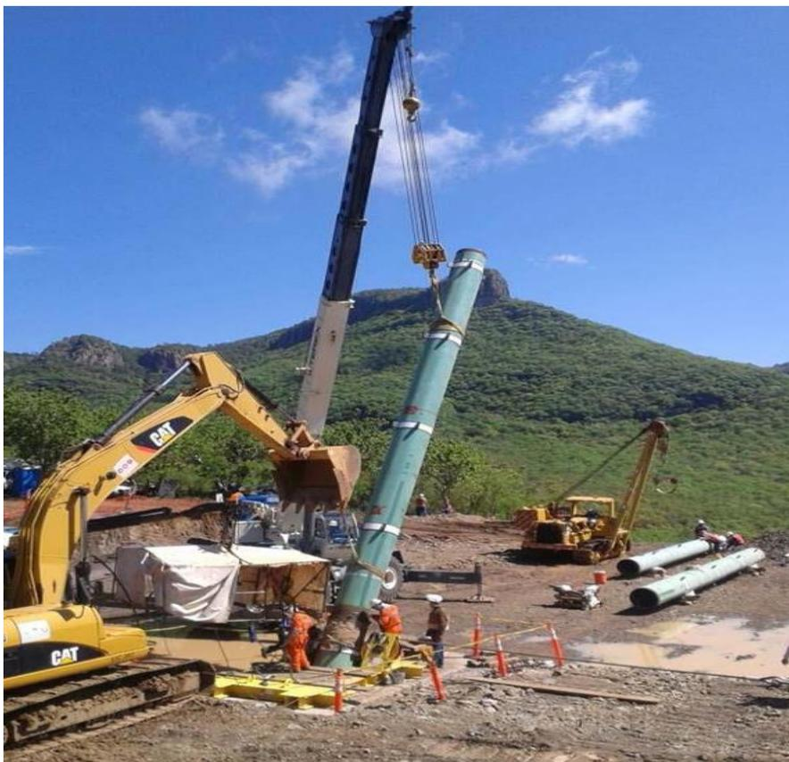
Fig. 5.1/C – Fase di varo della condotta (Immagine rappresentativa della lavorazione con diametro della condotta diverso da quello previsto in progetto)
