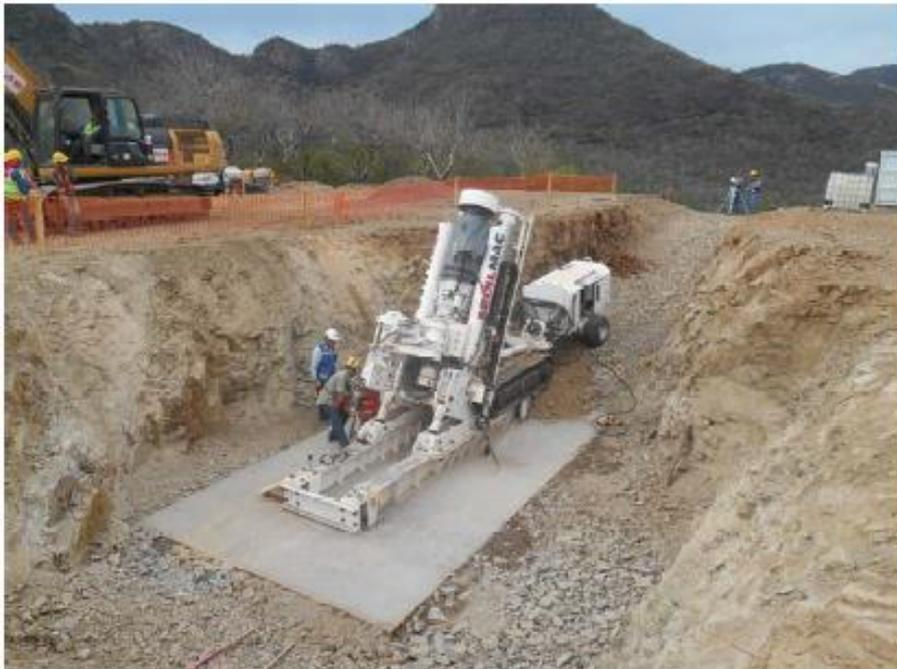
Fig.5.1/A - Esempio di macchina per perforazione "Raise Boring"
