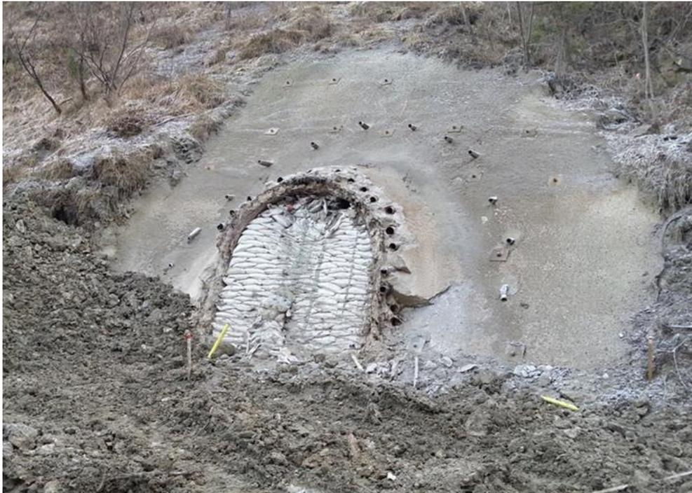
Fig.5.3/C – Esempio di Realizzazione chiusura galleria: posizionamento briglia in sacchetti TNT
