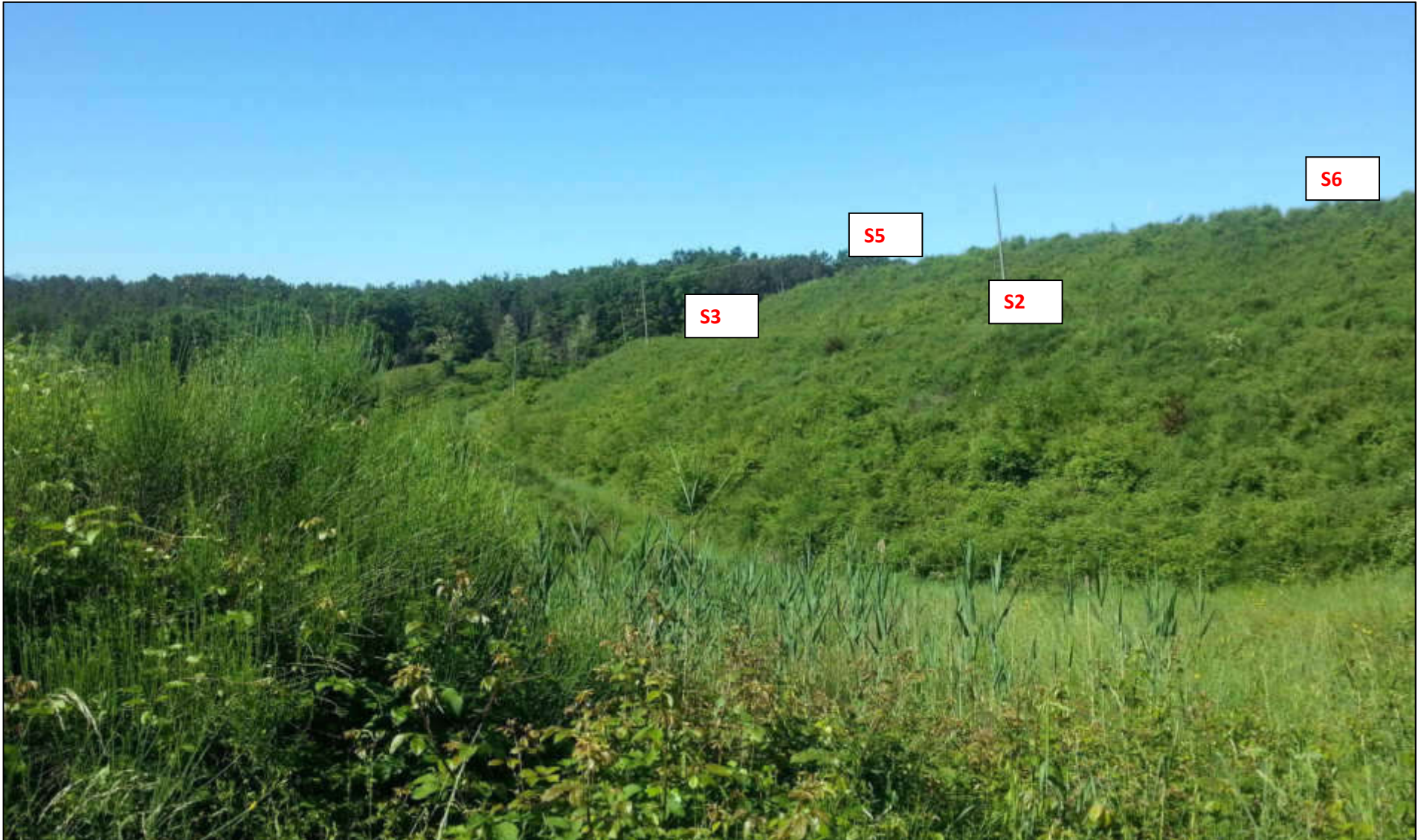
Panoramica lato valle Rilevato
