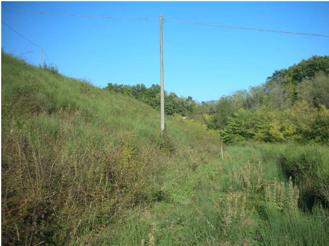
Figura 8-5: Vista dello sbarramento lato esterno
