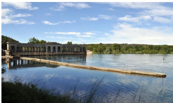
Figura 8-7 Il Fiume Ticino nei pressi della diga di Panperduto
