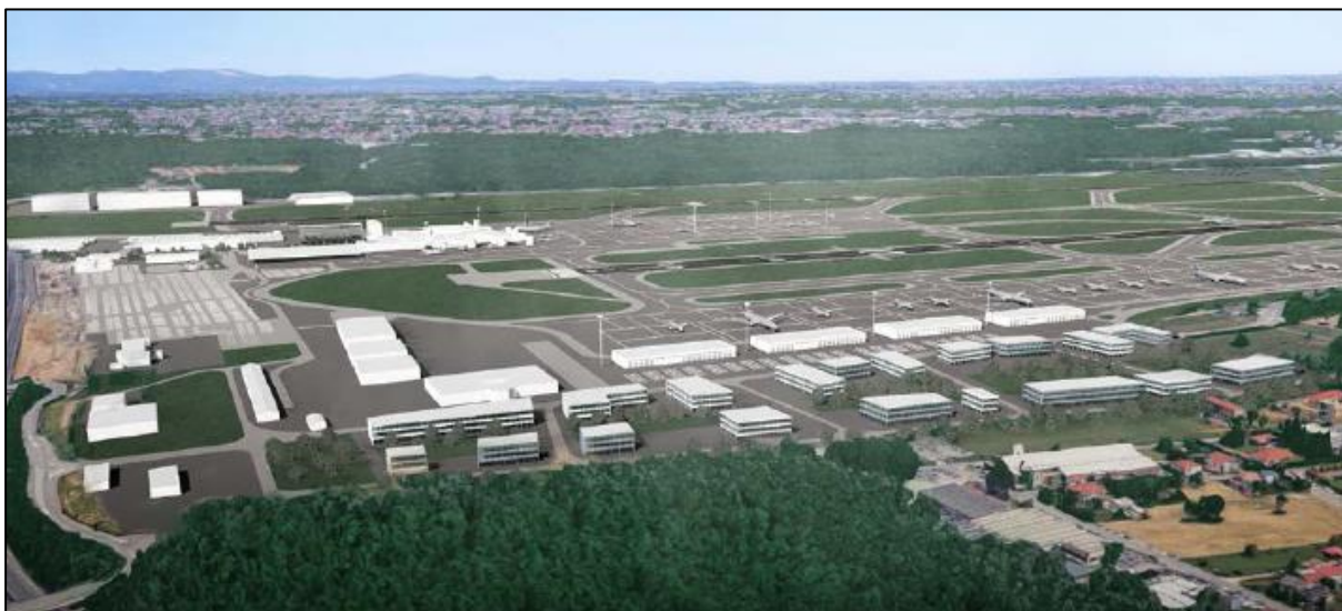
Figura 3-23 Intervento B2: Edifici servizi aeroportuali su sedime esistente, Edifici land side a nord-ovest del sedime dell'aeroporto, foto simulazione degli uffici di supporto
