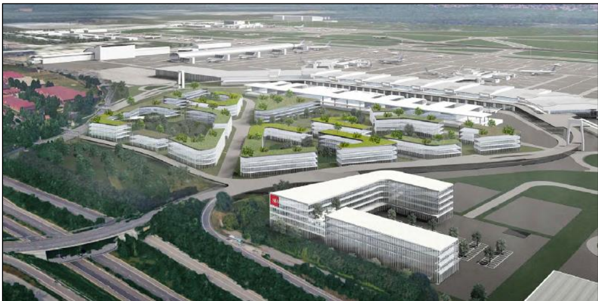
Figura 3-21 Intervento B2: Edifici servizi aeroportuali su sedime esistente, Headquarter SEA, foto simulazione
