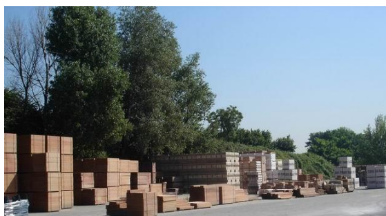
Area per il deposito materiale
