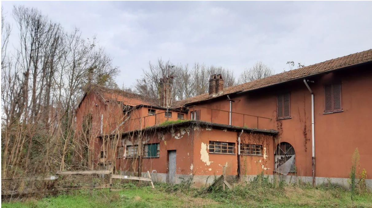
Figura 8-24 Cascina Malpensa: Angolo Nord-Ovest (foto dall'esterno)
