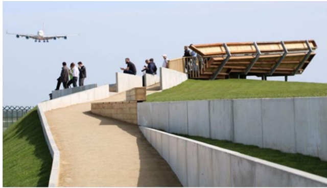
Bruxelles – Spotting platform di lungo pista
