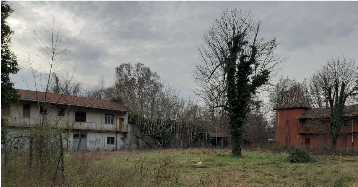
Figura 8-23 Casina Malpensa: Angolo Sud-Ovest (foto dalla corte interna)
