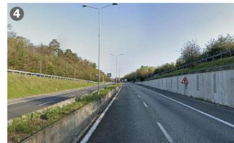
Le condizioni di visibilità impossibile si hanno nei tratti in cui la SS336 si sviluppa in trincea ed in affiancamento ai muri di sostegno di altre infrastrutture stradali. Medesime condizioni si hanno in corrispondenza delle rampe di ingresso ed uscita degli svincoli
