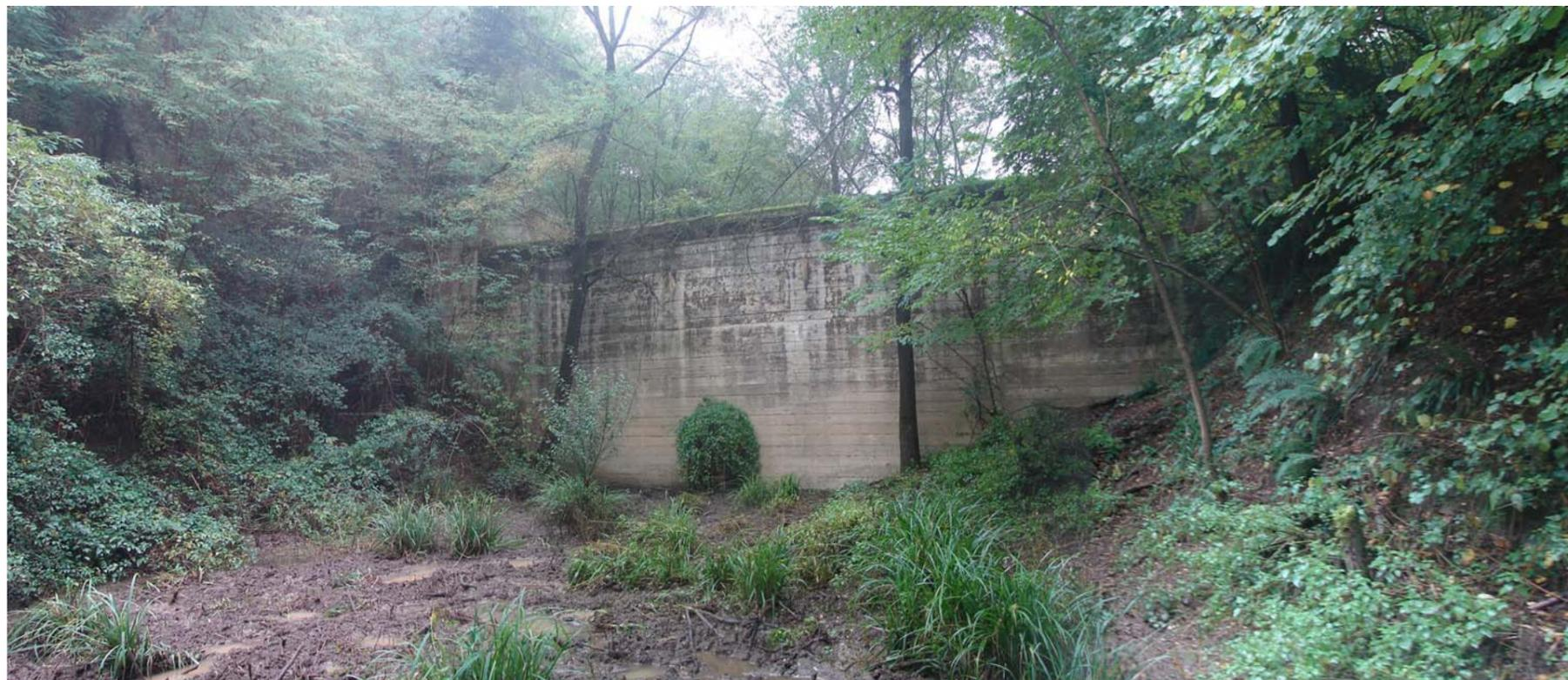
**Foto 1a:** Stato attuale dello sbarramento a gravità massiccia in calcestruzzo
