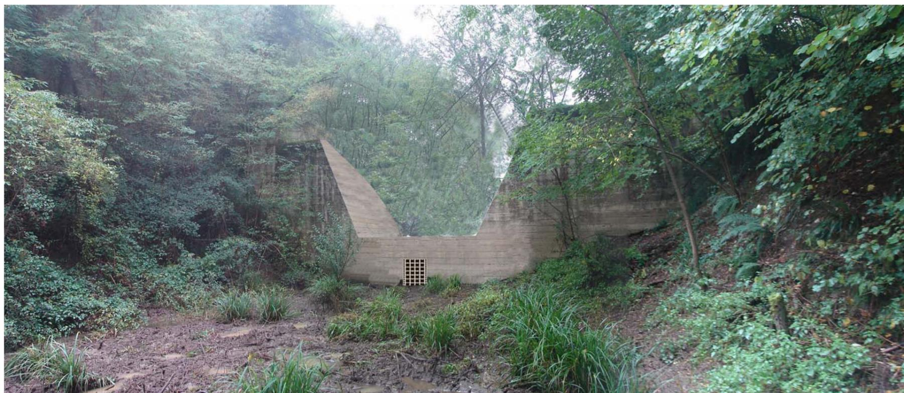
**Foto 1b:** Simulazione dello sbarramento a gravità massiccia in calcestruzzo dopo la demolizione parziale
