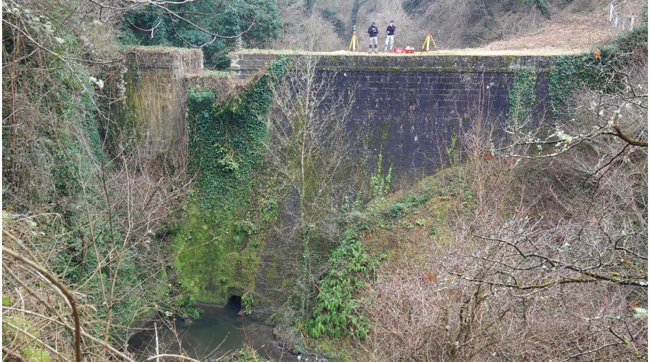
Figura 2-2: Sbarramento SG01 Pianale – Paramento di valle
