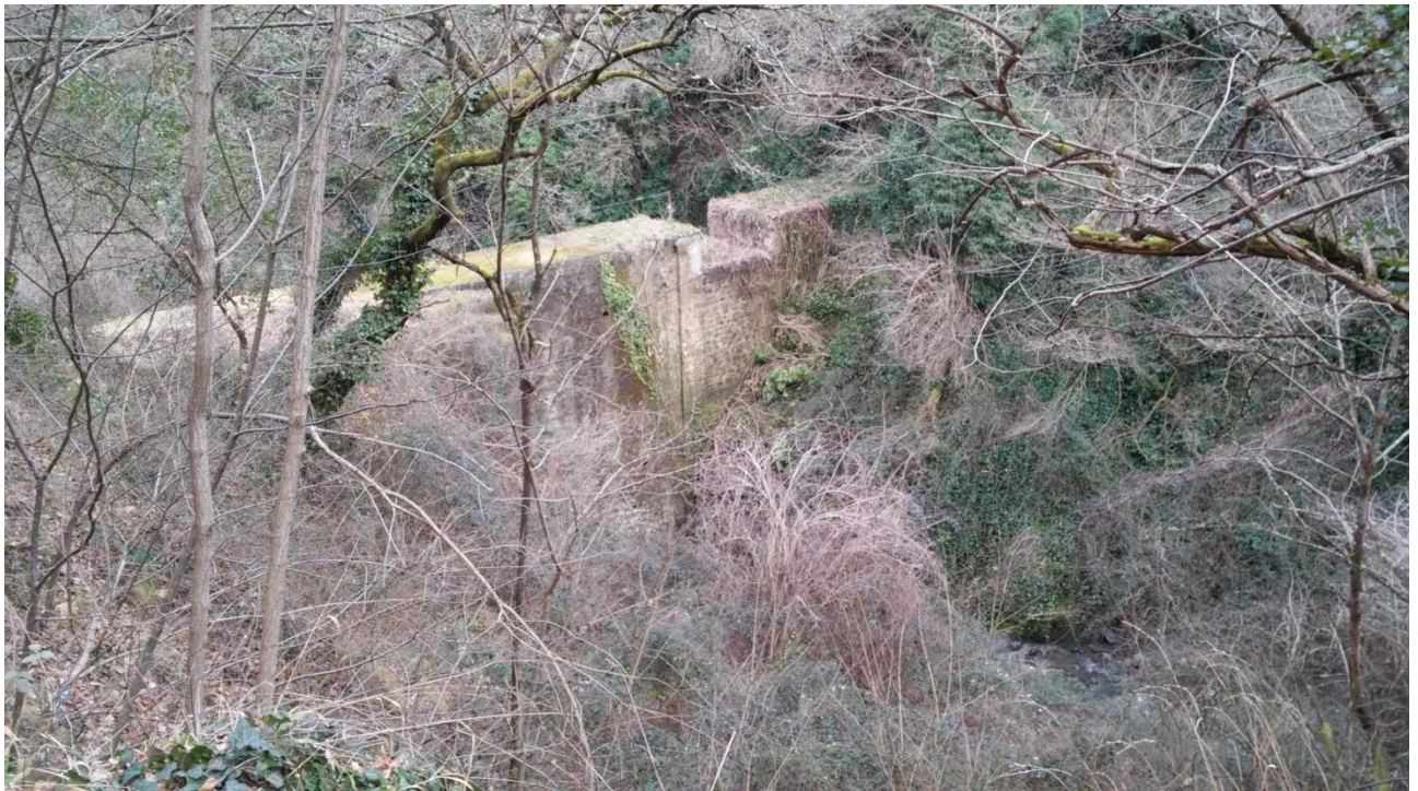
Figura 2-3: Sbarramento SG01 Pianale – Paramento di monte
