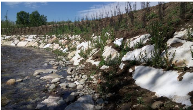
Scogliera in massi rinverdita, torrente Lura (Comuni di Bregnano e Lomazzo, Provincia di Como)
