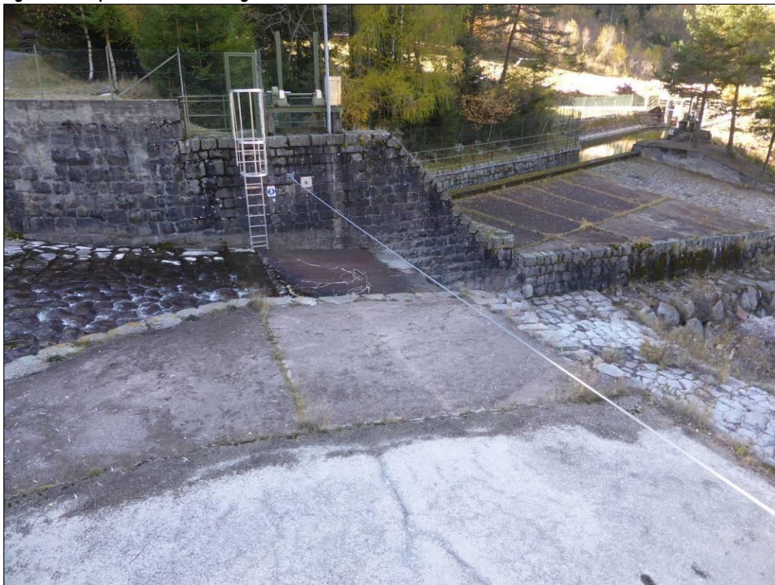
Figura 3-2: la presa sul Rio Brusago
