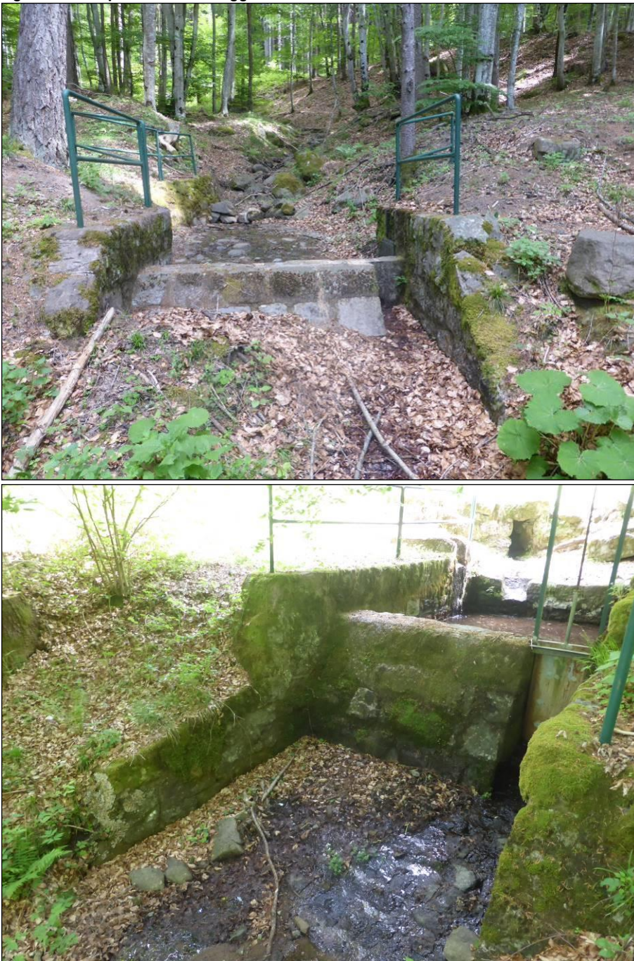
Figura 3-14: le prese sul Rio Roggia
