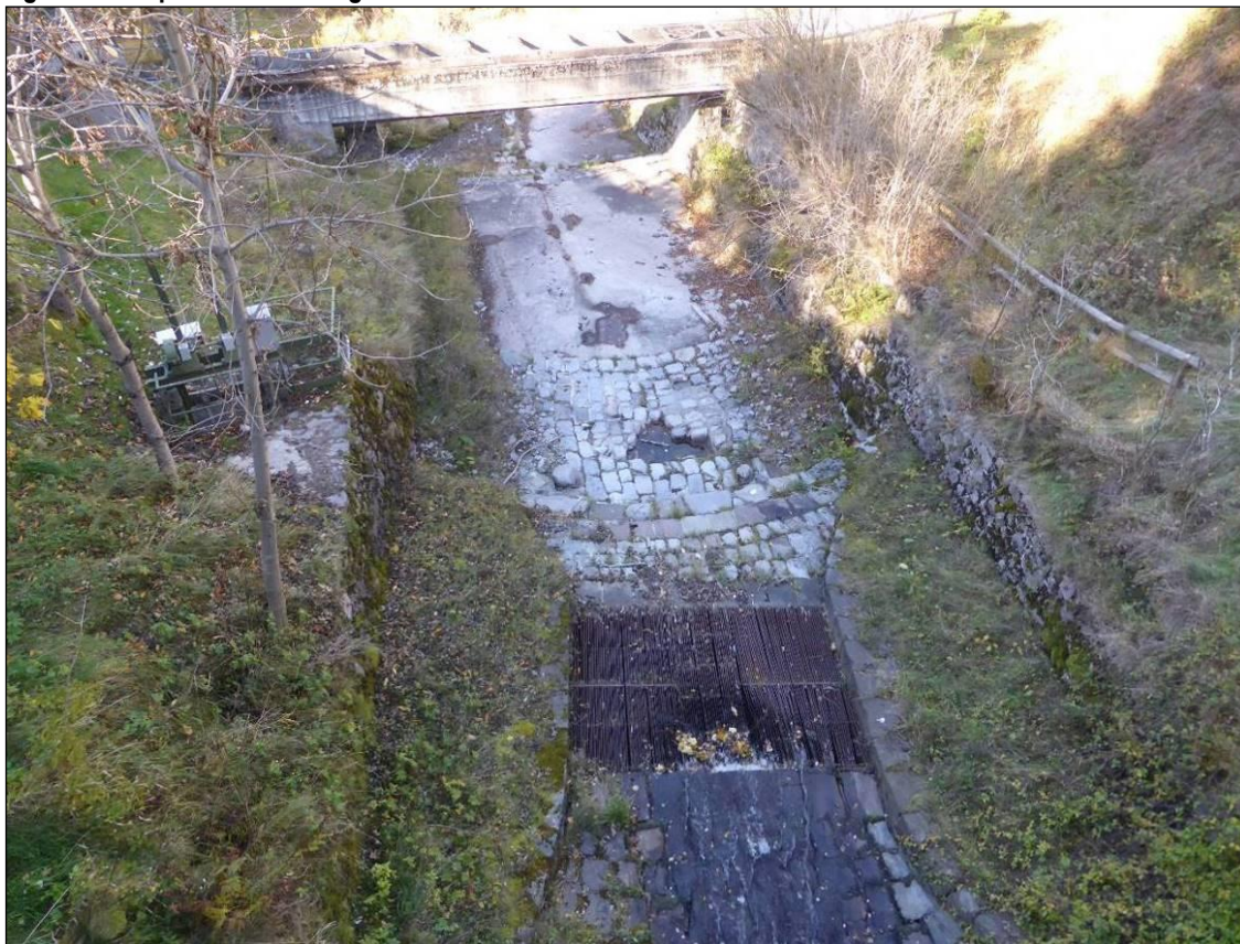
Figura 3-6: la presa sul Rio Regnana
