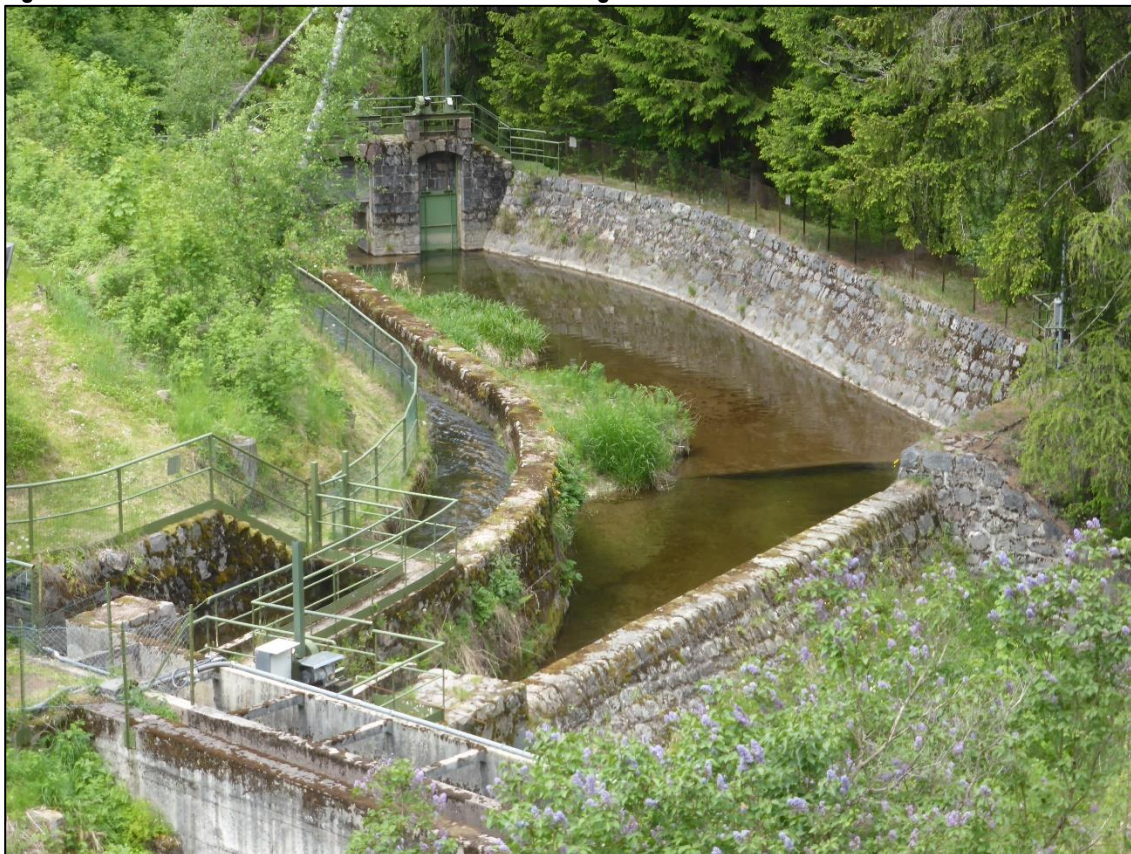
Figura 3-7: la vasca di carico della derivazione sul Rio Regnana
