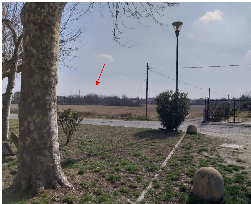
Figura 3: Fotografia scattata dalla Chiesa della Madonna della Mercede da cui si intravede il camino del comprensorio FCA, adiacente all'impianto Avio (indicato con la freccia rossa).
