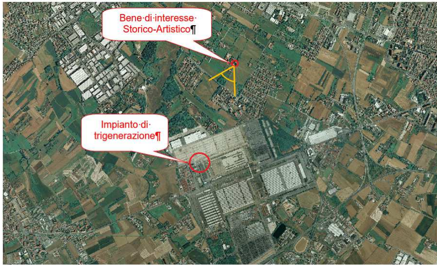
Figura 2: Individuazione della Chiesa della Madonna della Mercede rispetto all'impianto di trigenerazione e indicazione dell'orientamento della fotografia in Figura 3.
