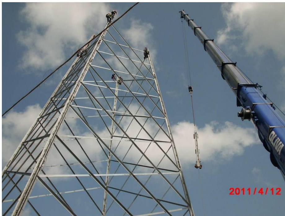
Figura 28 - Fasi di montaggio sostegno a traliccio
