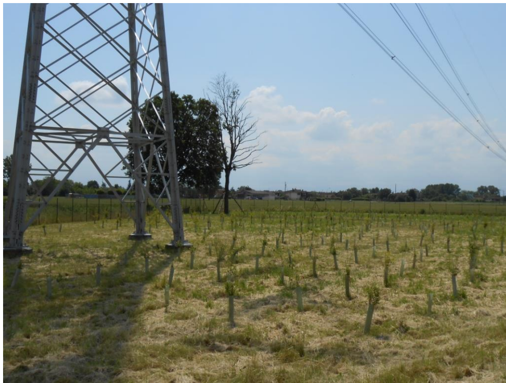
Figura 65 - Intervento di messa a dimora di alberi e arbusti sulla linea 380 kV Chignolo Po – Maleo
