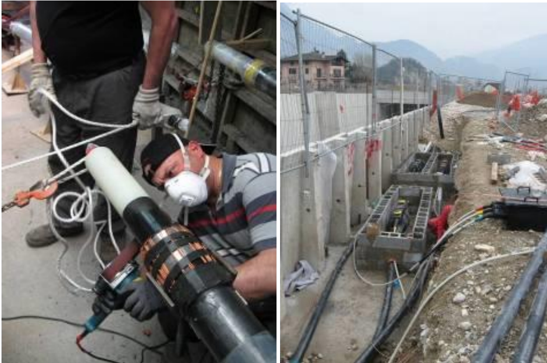
Figura 51 - Esecuzione giunto esempio di buca giunti
