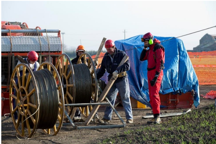
Figura 36 - Fasi di tesatura della linea elettrica
