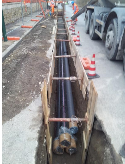
Figura 45 - Rinterro con posa delle tubiere
