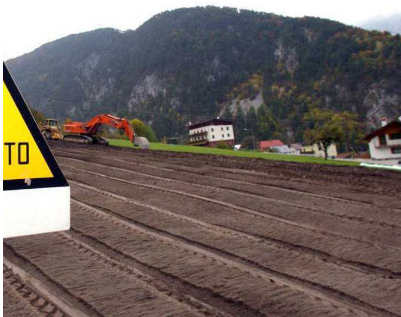
Fig. 3.3 - Ridistribuzione dello strato humico superficiale.
