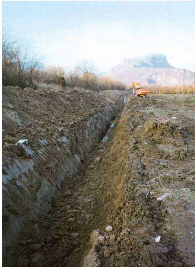
Fig. 3.2 - Operazione di rinterro della condotta.
