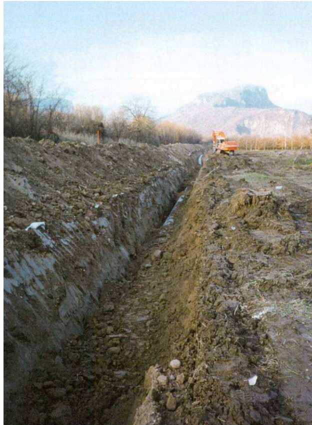
Fig. 3.2: Operazione di rinterro della condotta.
