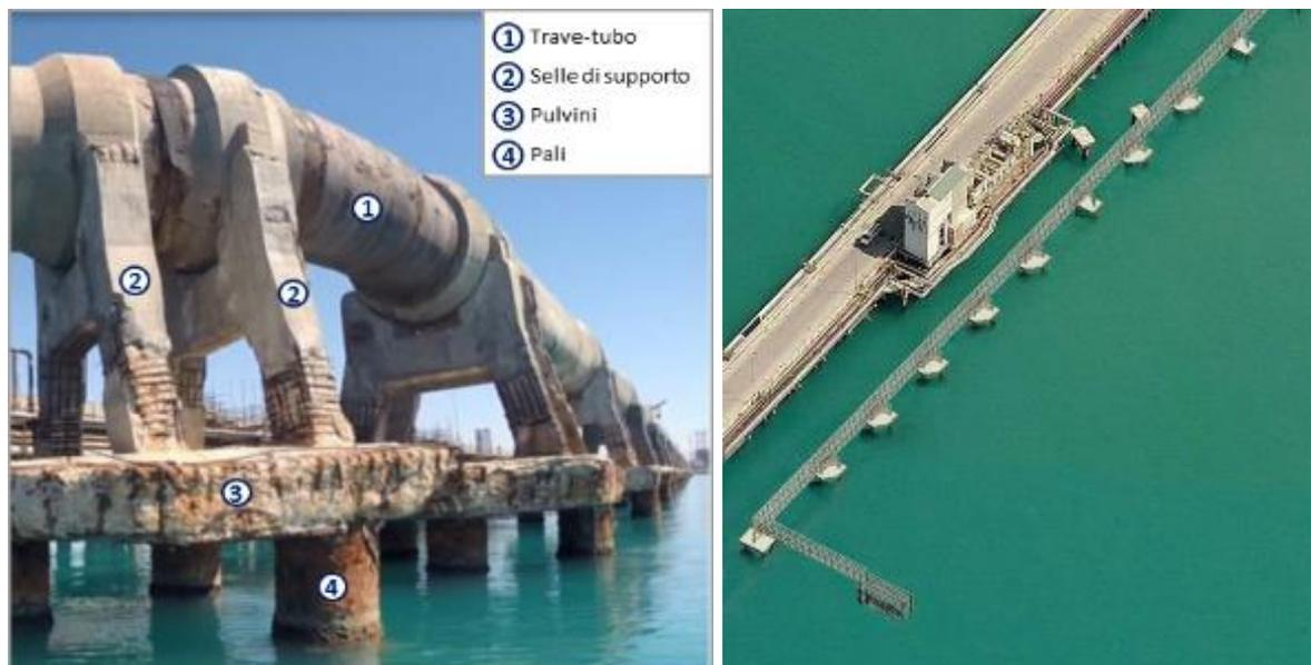
**Figura 2-5: A sinistra stato attuale della struttura, a destra Rendering della struttura in carpenteria metallica di supporto per la condotta di trasporto idrocarburi diametro 14”**
