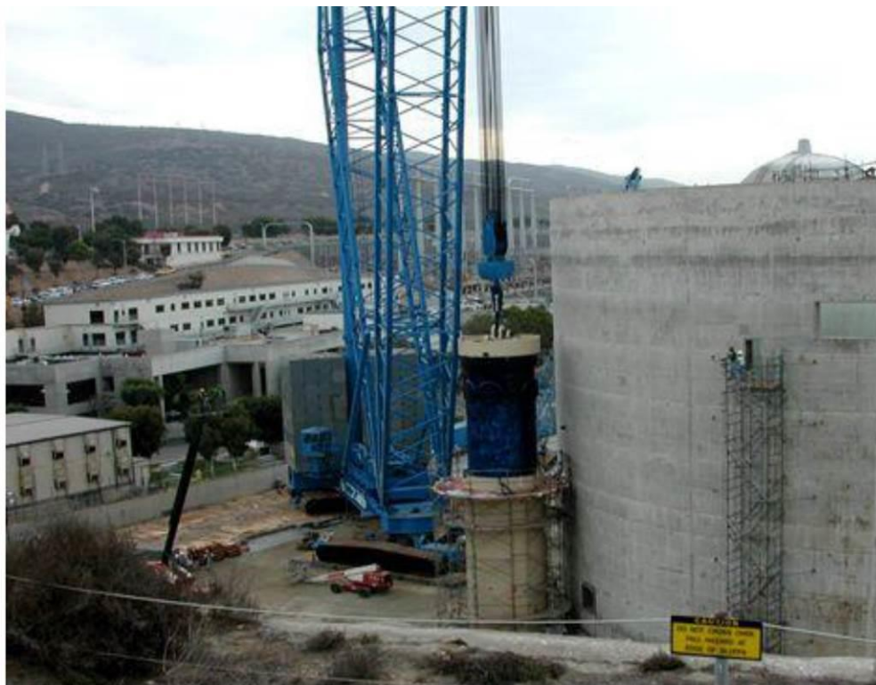
Figura I-10. San Onofre RPV viene depositato all'interno contenitore per la spedizione
