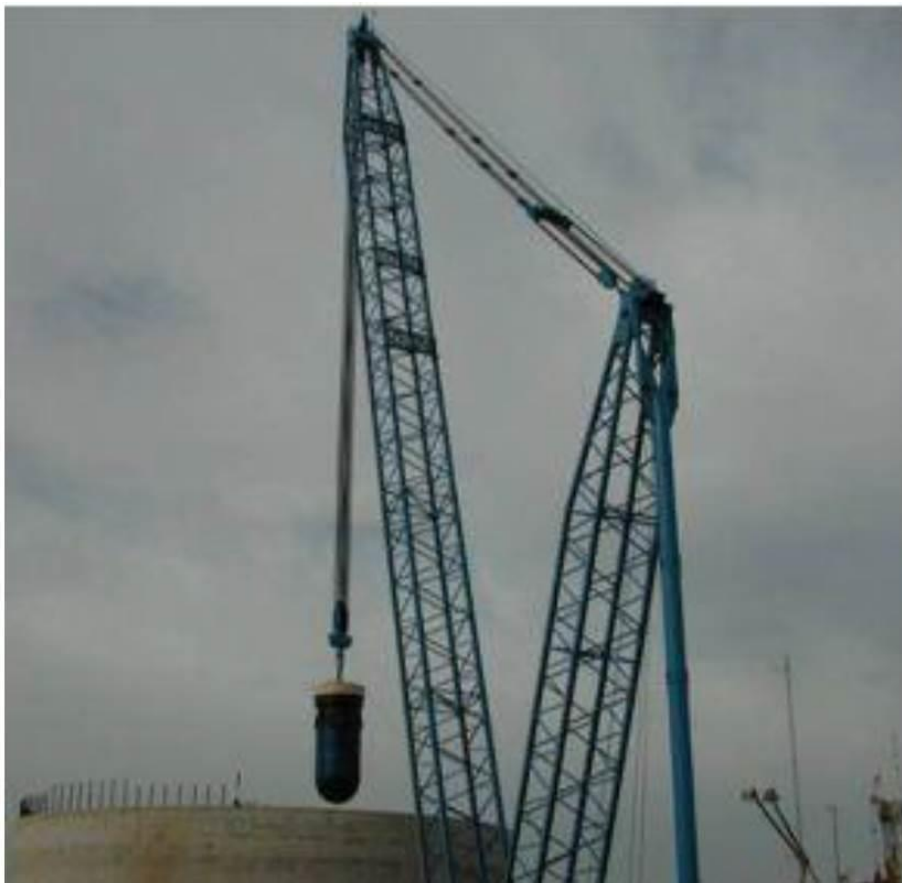
Figura I-9. San Onofre RPV viene sollevato dall'edificio di contenimento
