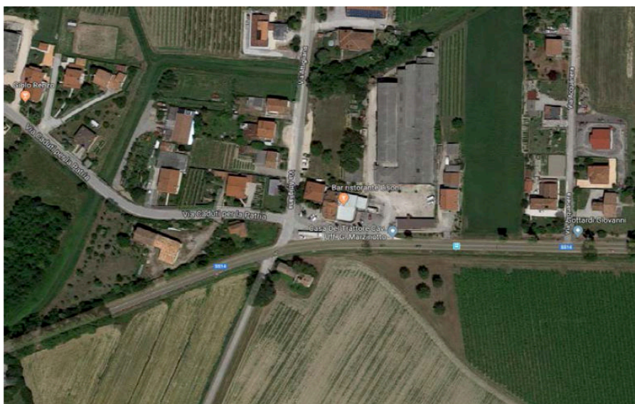
Fig. 1: Aerofoto dell'intersezione nello stato di fatto (Fonte: lista di controllo)
