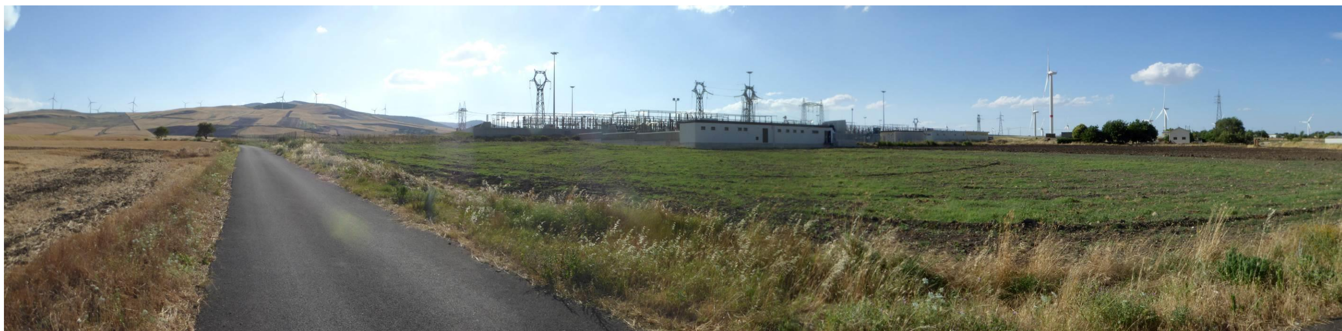
Figura 5: Panoramica dell'area della stazione RTN Deliceto
