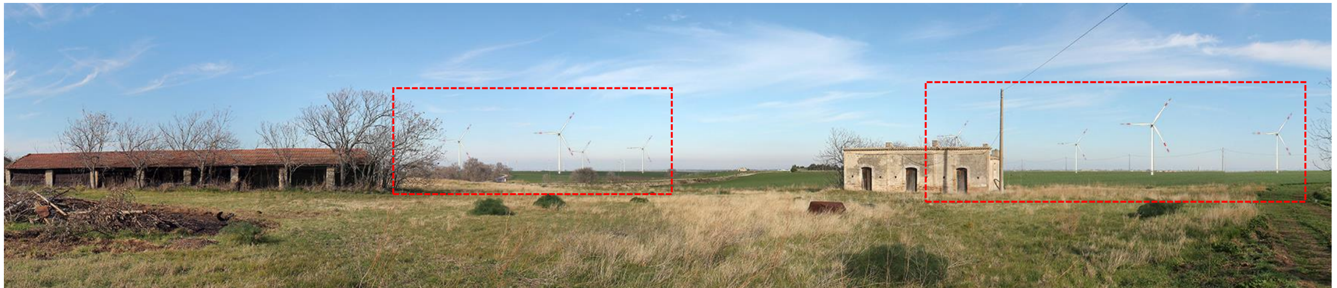
Panoramica 09 _ Confronto tra stato di fatto (in alto) e progetto (al centro e in basso nella vista ingrandita). Vista dalla Masseria Conte di Noia, a circa 1 km dall'impianto eolico (nei 2 riquadri rossi).
