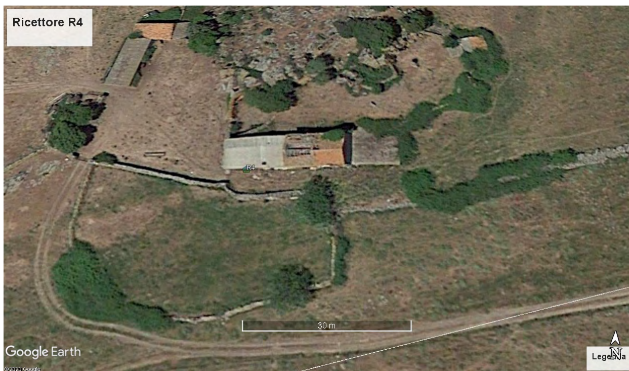
Figura 2 Ricettore R4, particolare con tetto crollato, presenza di alberature di alto fusto che schermano l'edificio
