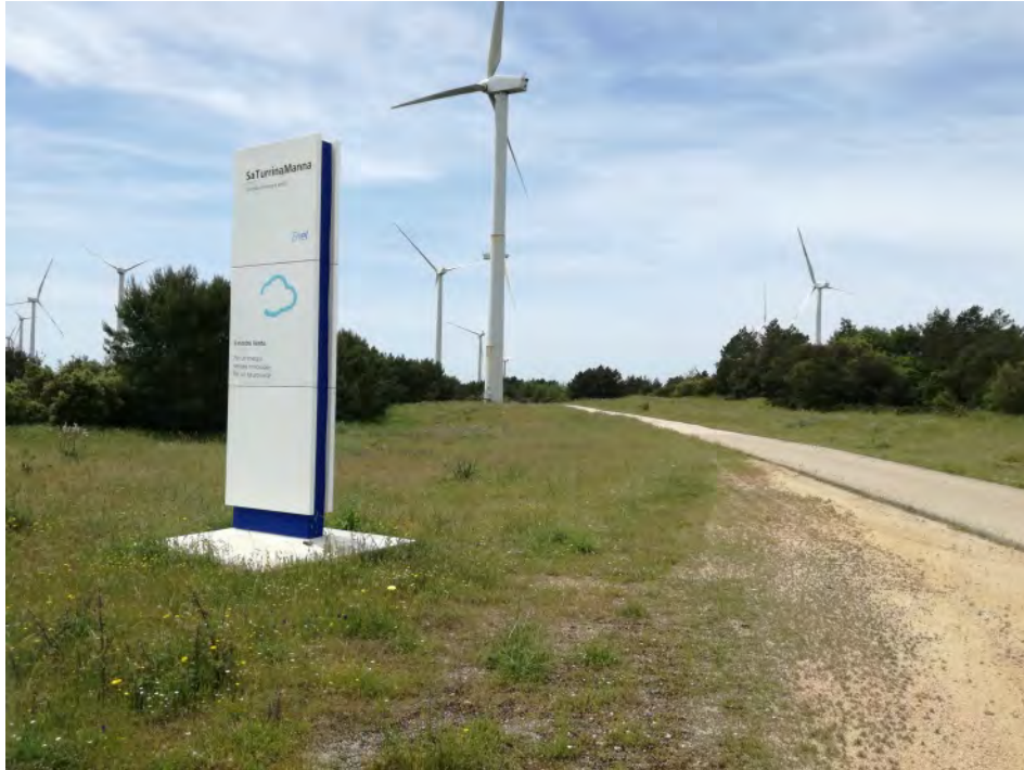
UR 25: l'area di inizio del tracciato dei cunicoli in progetto nel parco eolico di "Sa Turrina Manna"
